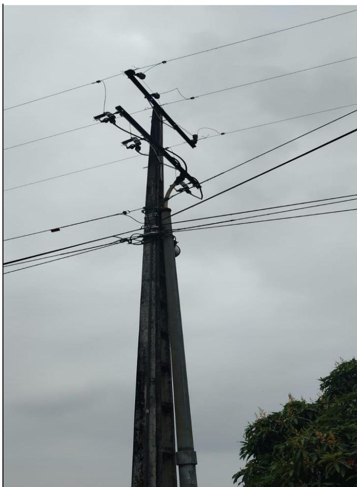
*Nota:* Se muestra el Cable conexión MT XLP 2/0 del último poste de planta la toma
