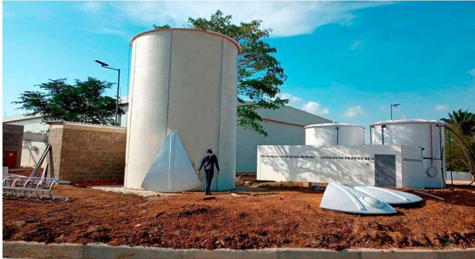
*Nota. Tanque de reservorio de agua. Estructura utilizada para almacenar agua potable antes de su distribución. Tomado de potableWeb,2022.*
