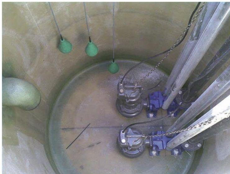
*Nota. Imagen de un pozo de bombeo para aguas residuales, estructura cilíndrica vertical construida en hormigón o material prefabricado, ubicada bajo el nivel del terreno. Tomado de Netjet, 2021.*
