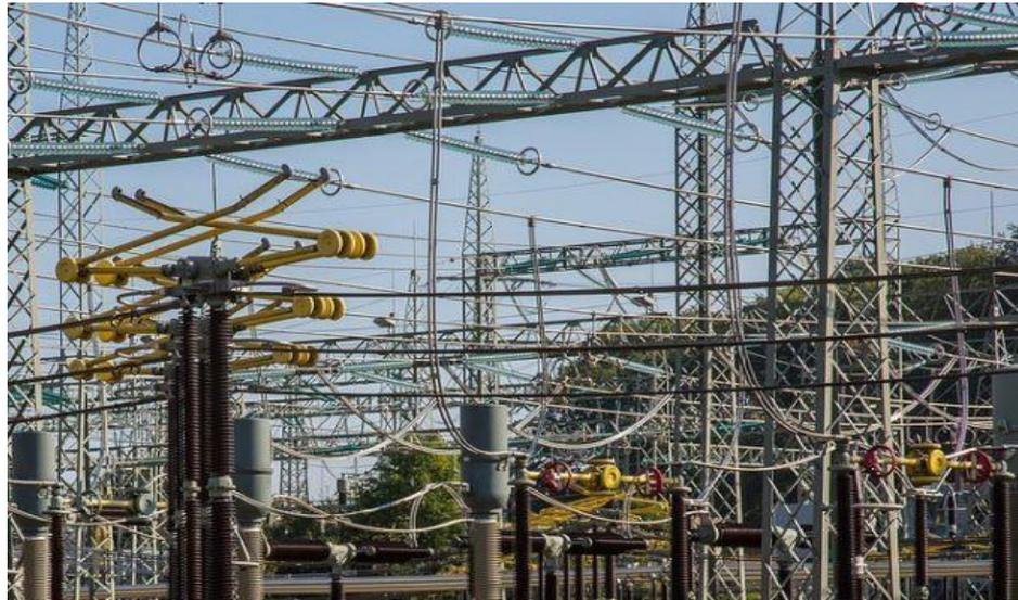
*Nota: Cuenta con un transformador reductor que disminuye los niveles de tensión para la distribución de energía en media y baja tensión; Fuente: CELEC EP, 2019*
