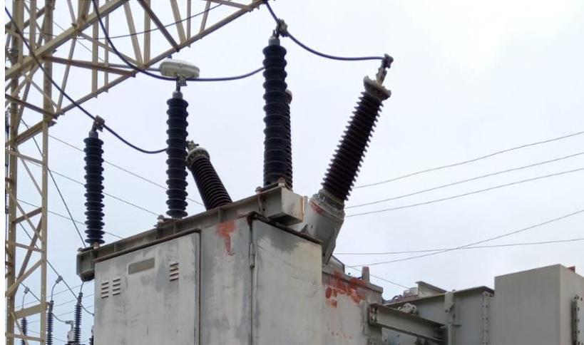
*Nota: Interruptor tanque muerto con presencia de corrosión en el chasis; Fuente: Autor, 2024*
