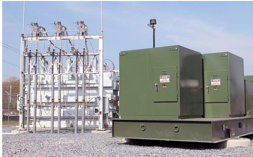
*Nota: Transformador de 20/24 MVA subestación eléctrica San Juan; Fuente: CNEL, 2024*
