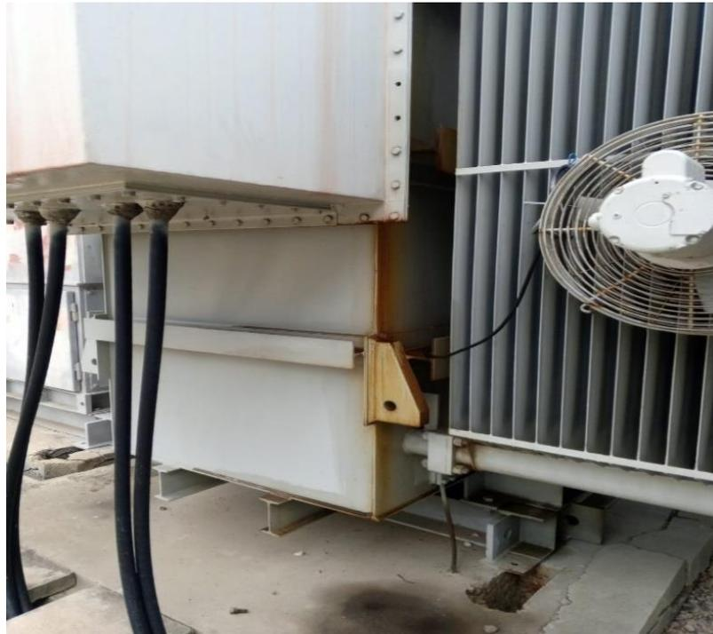
*Nota: Cuba del transformador en buen estado; Fuente: Autor, 2024*
