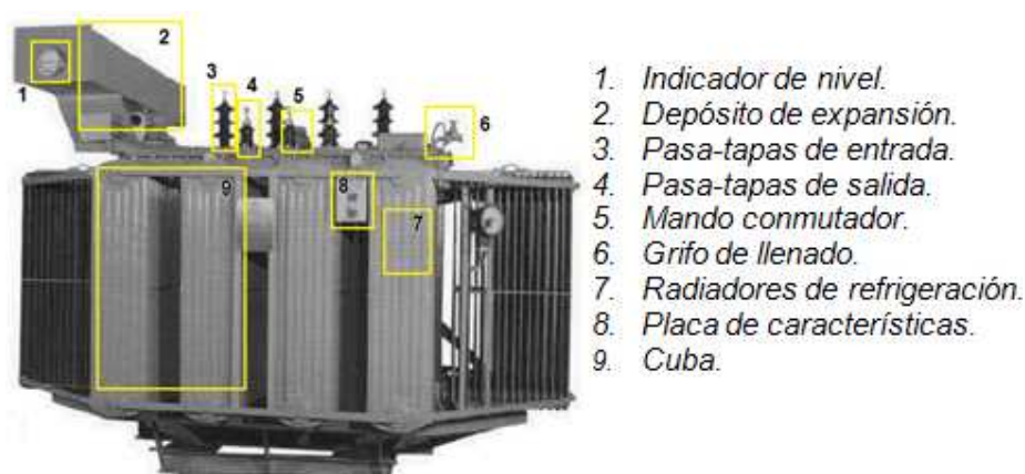
Figura 4. 16: Elementos que componen el Transformador trifásico.
