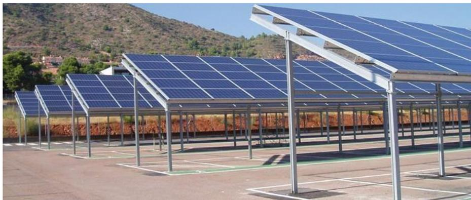
*Figura 2. 18. Estructura elevada con riel para paneles solares
