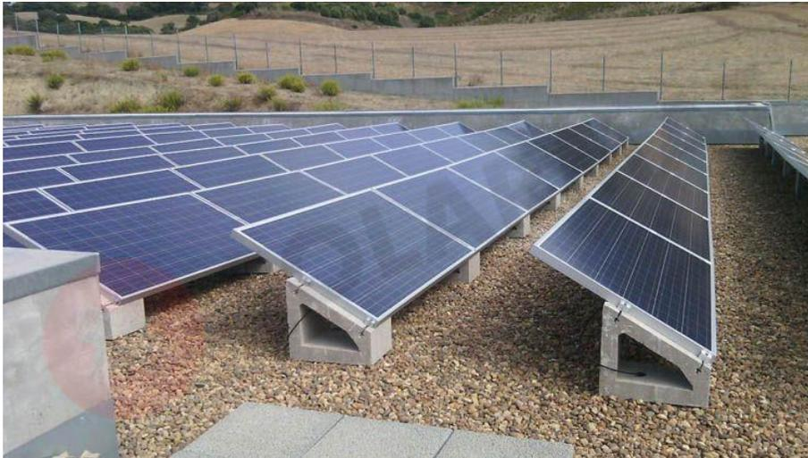
*Figura 2. 17. Estructura autosoportada para paneles solares
