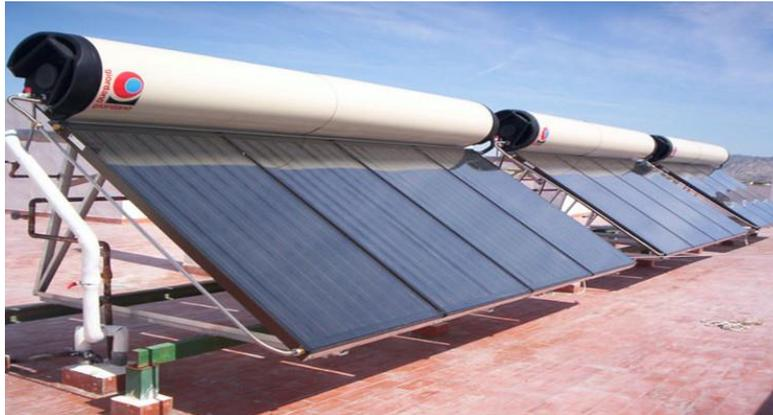
*Figura 2. 9. Captador solar plano
