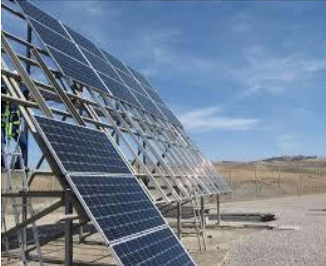
*Nota: Soporte fabricado en aluminio para soportar paneles solares los cuales comprenden riel de aluminio, conector tipo L, taco químico, grapa media, grapa final y conector riel. Adaptado de: (Coronatodays, 2025)*
