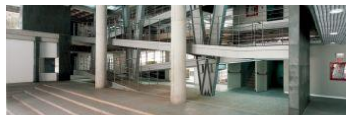
IMAGEN 30: Columnas de hormigón y rampas de acero FUENTE: Plataforma Arquitectura, 2014
