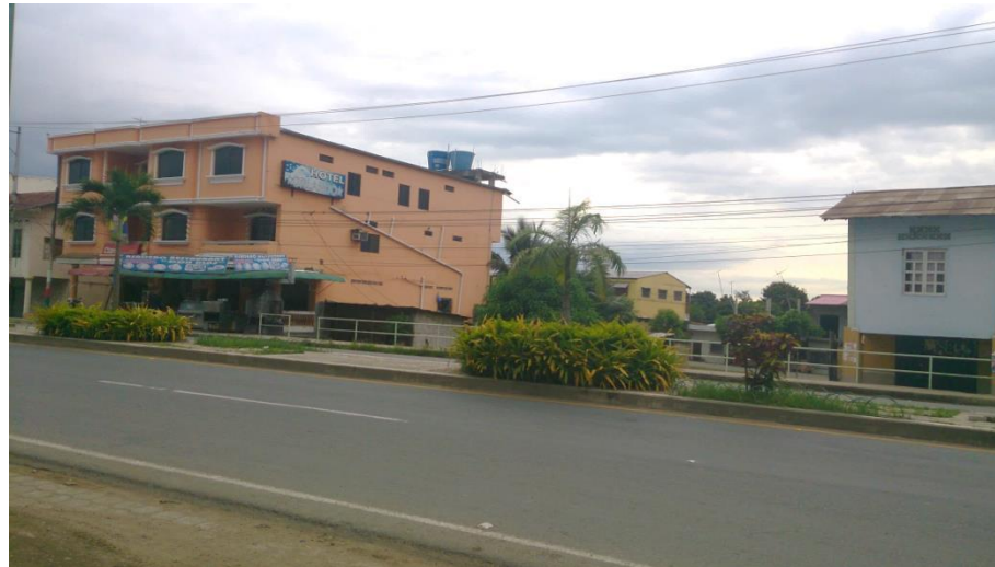
IMAGEN 13: Edificaciones junto al terreno FUENTE: Lucas Noboa, 2014
