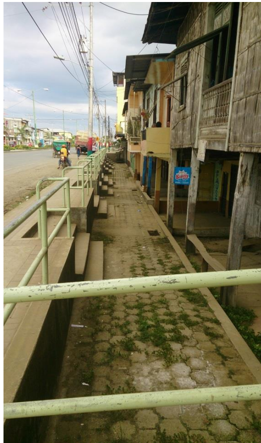
IMAGEN 16: Soportales en la vía principal FUENTE: Lucas Noboa, 2014
