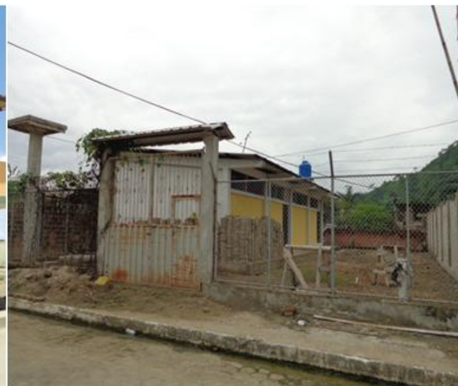
Figura 3: Cadis-infocentro de la parroquia La Unión. Fuente: Gobierno Autónomo Descentralizado de la Parroquia Rural San Plácido (2011)
