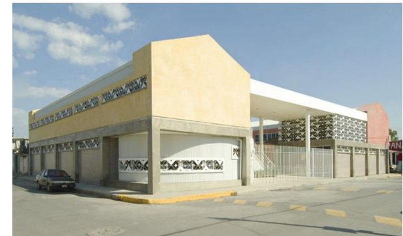
Figura 51: Fachada principal centro comunitario. Fuente: Plataforma arquitectura, (2014)
