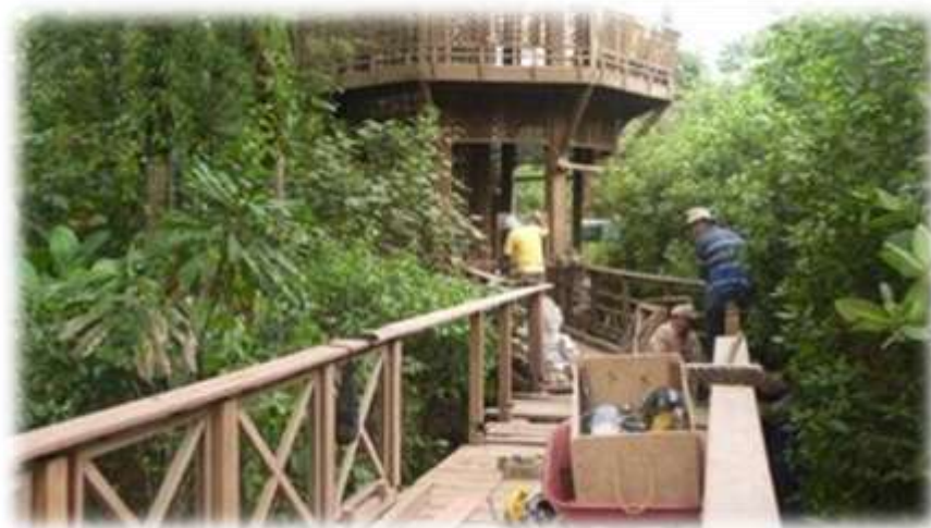
Ilustración 26 Trabajos en el sendero Fuente: Ministerio de Ambiente Elaborado por: Ministerio de Ambiente
