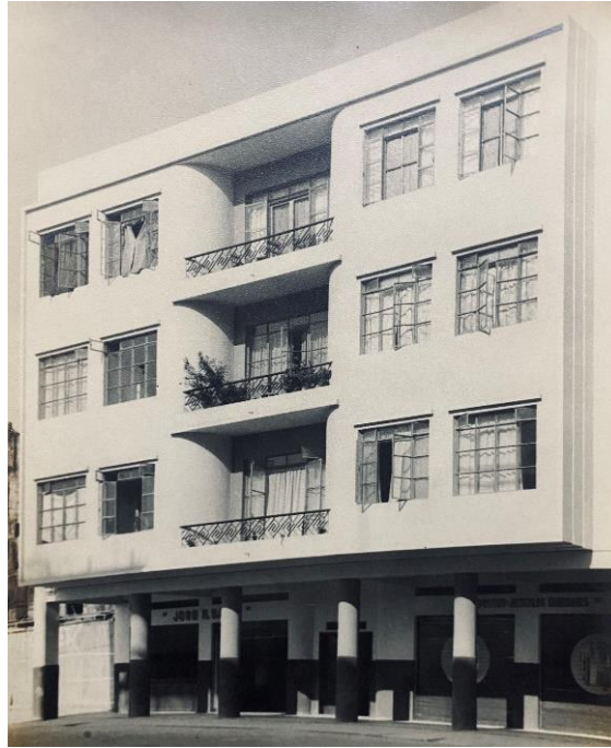
Figura 31: Edificio Saadi 2 (Archivo Rivas)
