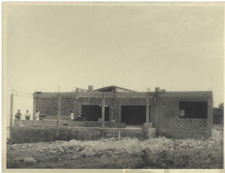
Figura 21: Construcción de casa en Urdesa (Archivo Rivas)
