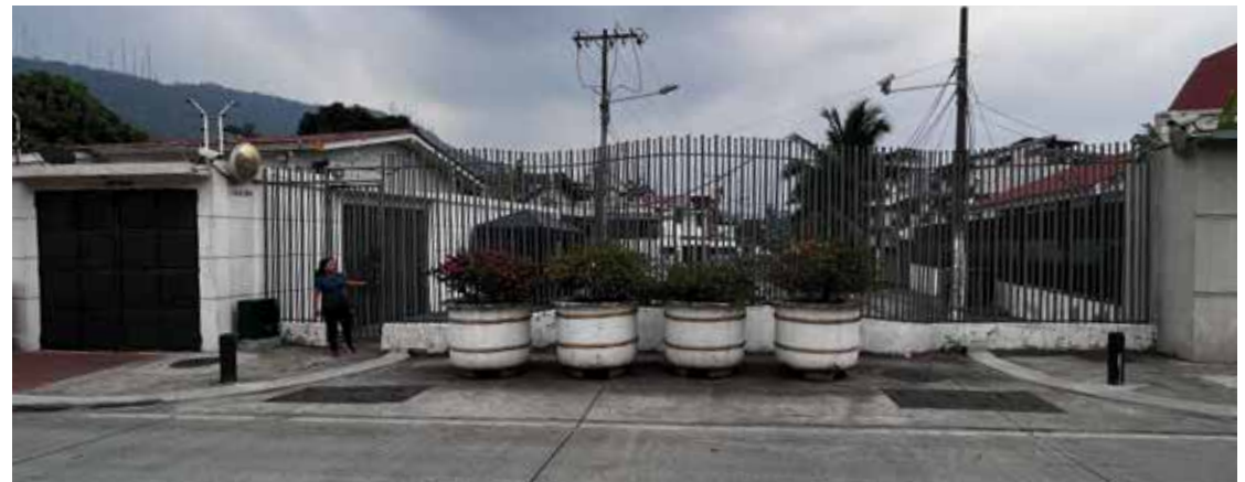
Gráfica 17: Foto cerramiento Fuente: fotografía propia
