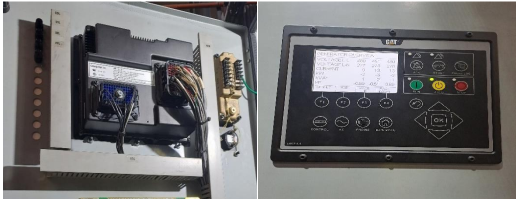
Figura 44 Montaje panel de control Emcp4.4
