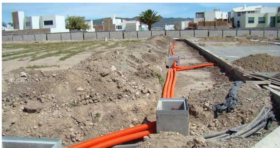
*Nota: La figura muestra la instalación de un banco de ductos PVC tipo TDP de 6 x 110mm Fuente: CFE, 2008*
