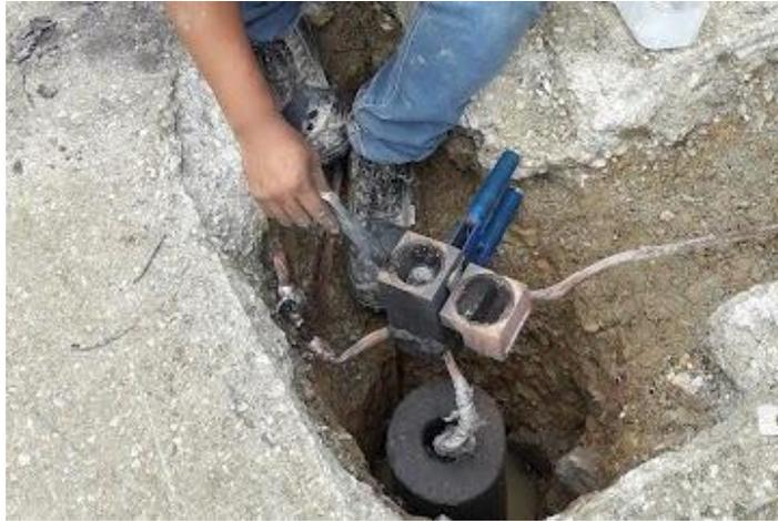
Nota: Instalación de molde para establecer la unión de las barras del sistema. Foto tomada por: El Autor
