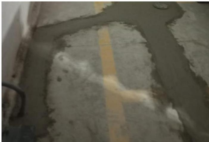
Nota: Finalización del llenado del trayecto utilizado para el sistema de puesta a tierra. Foto tomada por: Autor
