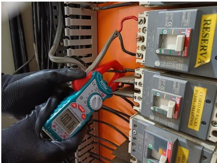
Nota: Registro de 0,16A del multímetro en la línea A. Foto tomada por: Autor
