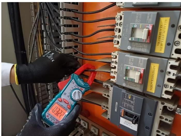
Nota: Registro de 3,22A del multímetro en la línea B. Foto tomada por: Autor
