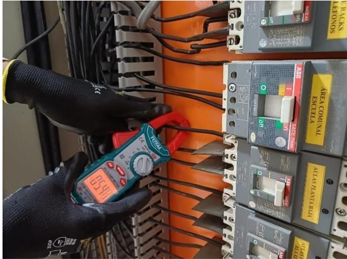
Nota: Registro de 5,41A del multímetro en la línea C. Foto tomada por: Autor
