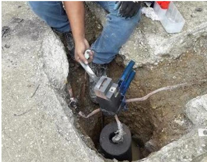
Nota: Colocación de material para realizar la soldadura exotérmica. Foto tomada por: El Autor
