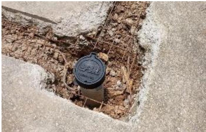
Nota: Tapa para acceder al interior del pozo del sistema a tierra cuando se necesite realizar una inspección o mantenimiento. Foto tomada por: Autor
