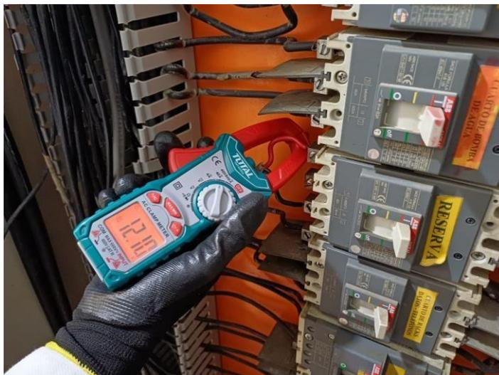
Nota: Registro de 12,1A del multímetro en la línea B. Foto tomada por: Autor
