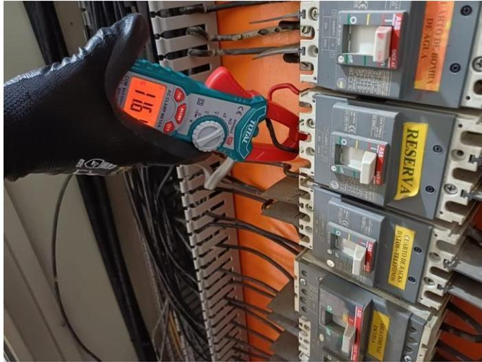
Nota: Registro de 11,6A del multímetro en la línea A. Foto tomada por: Autor
