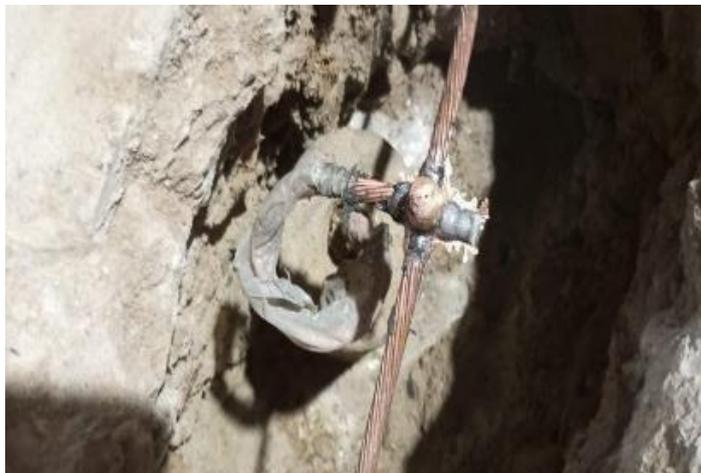
Nota: Unión del sistema de puesta a tierra donde las conexiones a tierra se encuentran y se unen. Foto tomada por: Autor
