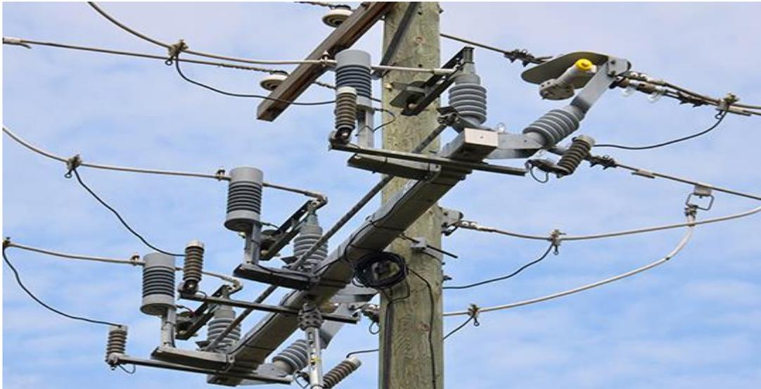
Nota: (CNEL, 2021) Pararrayos: Instalados para proteger la línea y los equipos conectados contra sobretensiones causadas por rayos.
