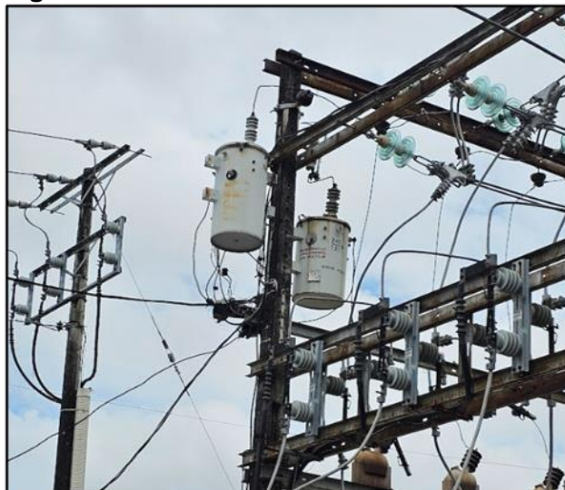
Figura 6. Servicios Auxiliares de la S/E Villa Club
