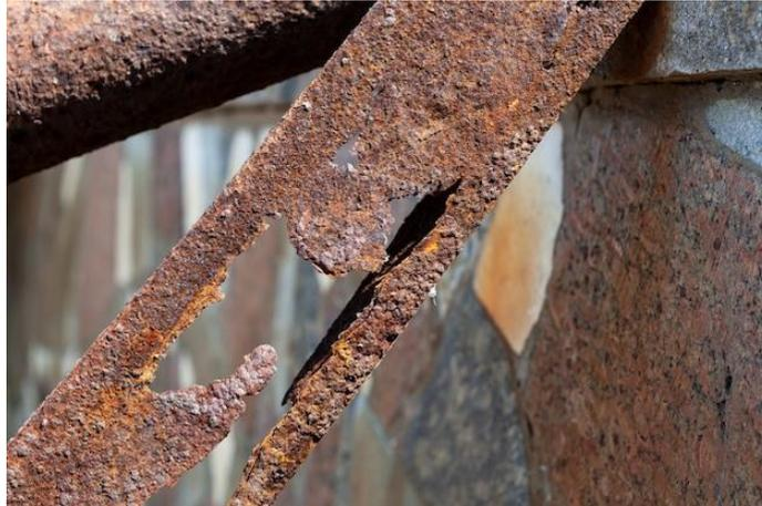
**Fuente:** (Freepik, 2022), en esta imagen se aprecia el nivel de deterioro de hierro por corrosión.
