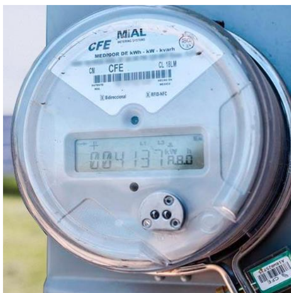
Figura 74: Ejemplo de medidor bidireccional para sistemas fotovoltaicos.
