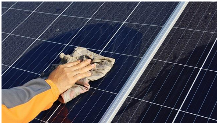
Figura 23: Limpieza de polvo en paneles solares.
