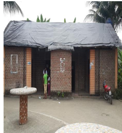
Imagen 22 .Servicios higiénicos Fuente: Imágenes propias in situ
