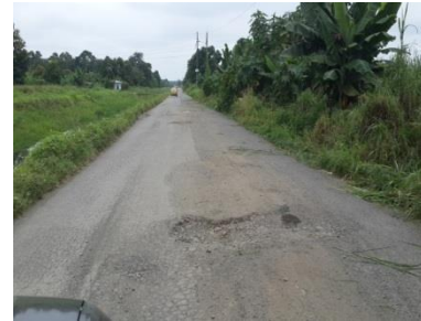
Imagen 19. Asfalto Fuente: Imágenes propias in situ
