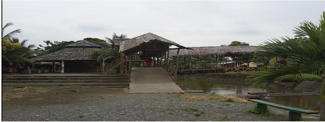
Imagen 4. Infraestructura turística deteriorada
