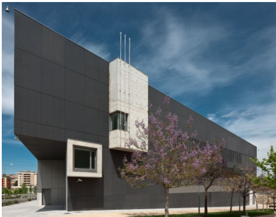
Figura 21. Fachada Oeste del edificio Instancia de Tudela Fuente: ArchDaily (2014)
