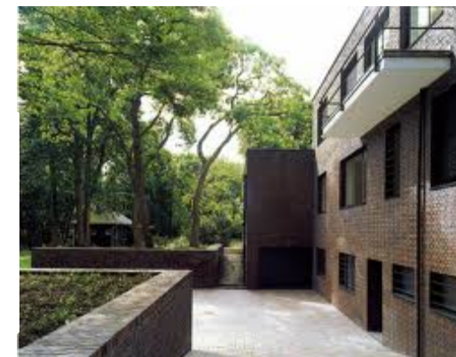
Figura 18. Fachada este, tipología 2 Fuente: Plataforma de arquitectura (2013)
