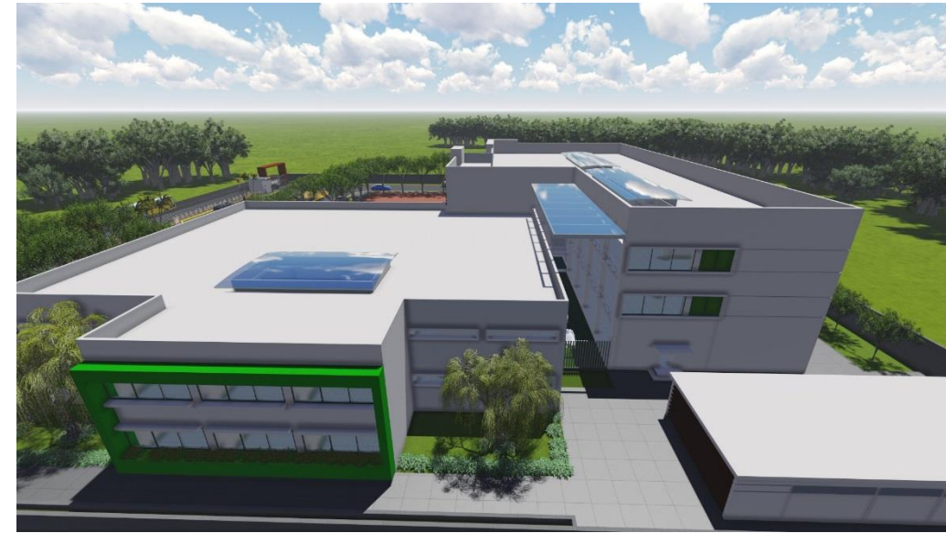
Figura 54. Fachada lateral derecho. Elaborado: José Javier Zambrano Chávez, 2014
