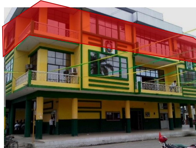
Figura 1. Edificio del Municipio del Cantón Salitre Planta segundo alto Elaborado: José Javier Zambrano Chávez, 2014
