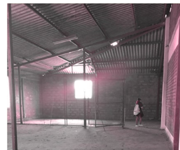
Figura 28: Visita al terreno del edificio Bodega de Pycca
