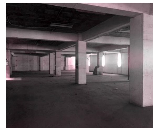
Figura 27: Visita al terreno del edificio Bodega de Pycca
