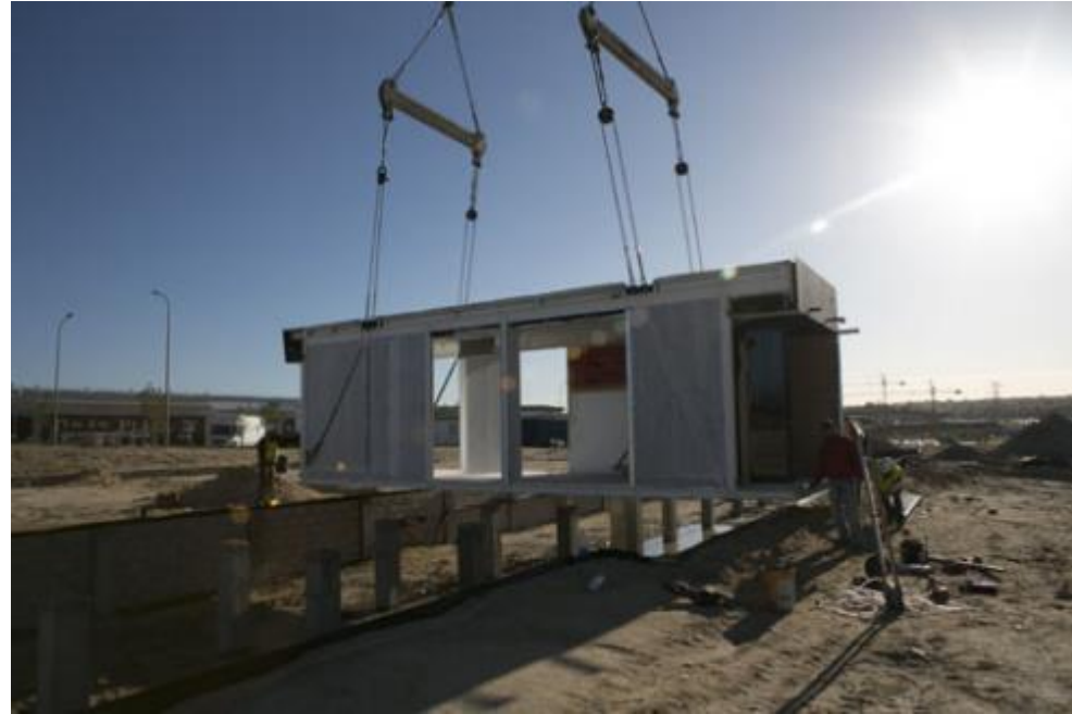
Figura 57.- Tipología 3. Instalación de módulos en el sitio. Fuente: Estudio de Arquitectura A-cero (2011)
