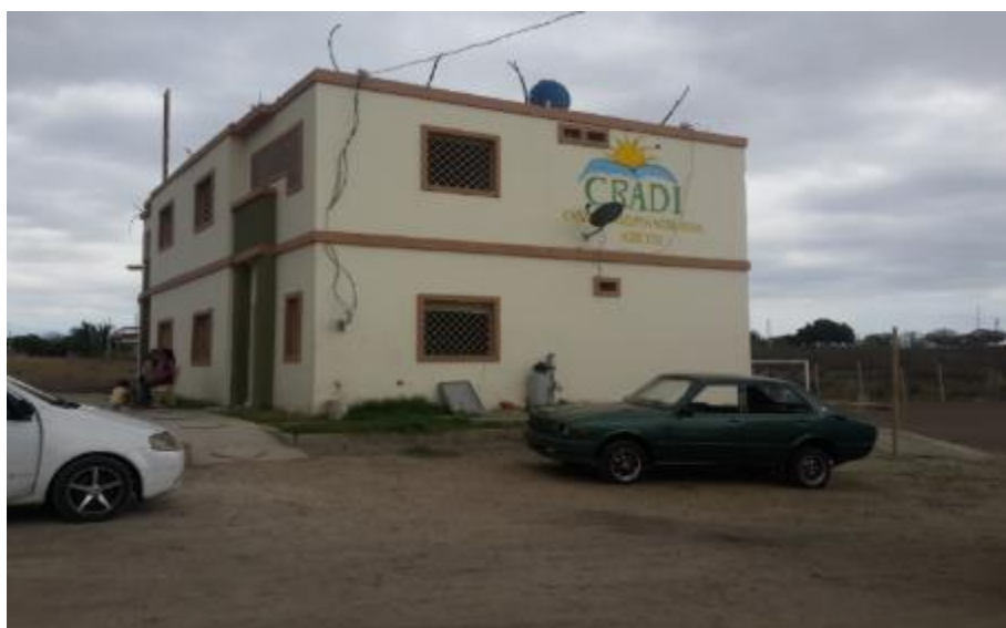
Figura 23.- Casa de recuperación para adictos – CRADI (Manta) Fuente: Autora
