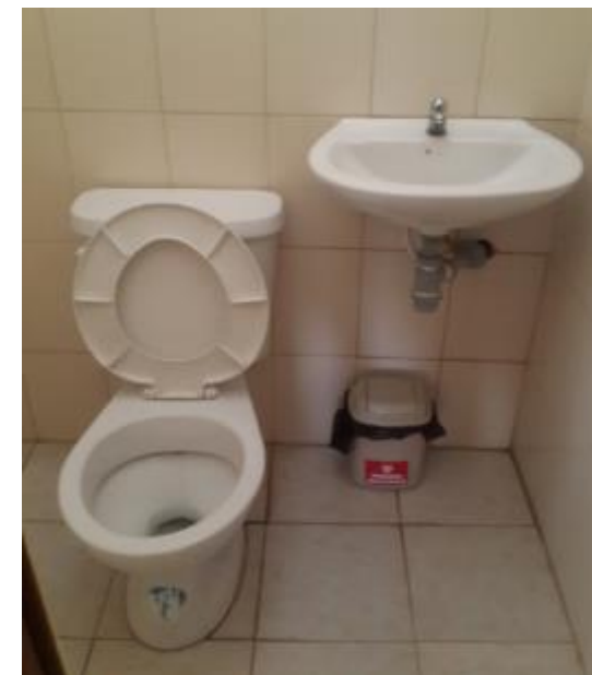
Figura 24.- Baños – CRADI (Manta) Fuente: Autora
