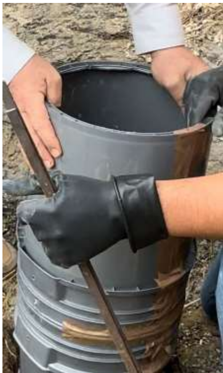
Figura 85. Introducción de la camisa de PVC en el suelo.
