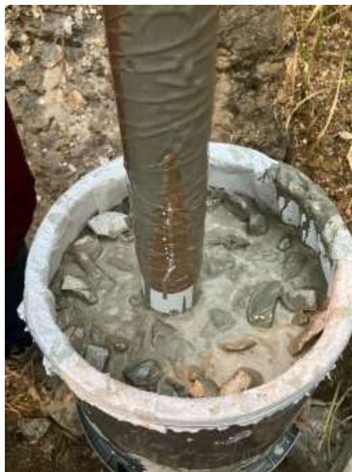
Figura 91. Columna de piedra durante la inyección.
