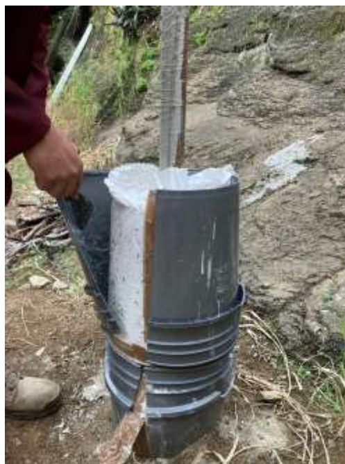
Figura 93. Retiro de la camisa de PVC.
