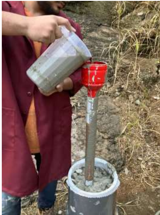
Figura 90. Columna de piedra siendo inyectada.
