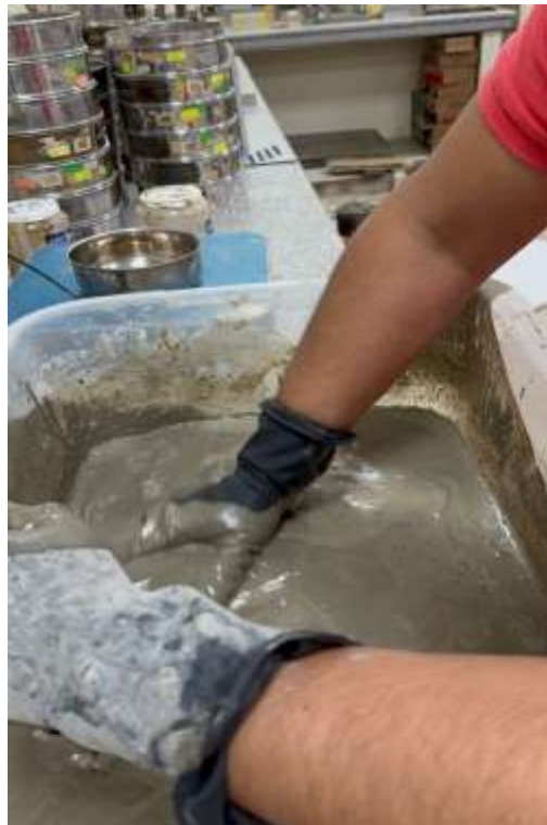
Figura 58. Elaboración de la lechada de cemento.
