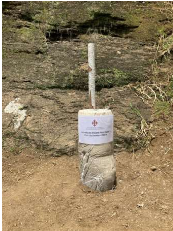
Figura 96. Columna de piedra inyectada y revestida con geotextil.
