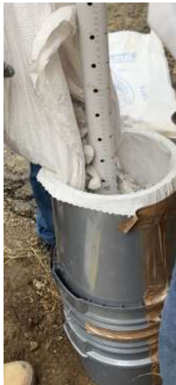
Figura 88. Colocación de piedra dentro del geotextil.
