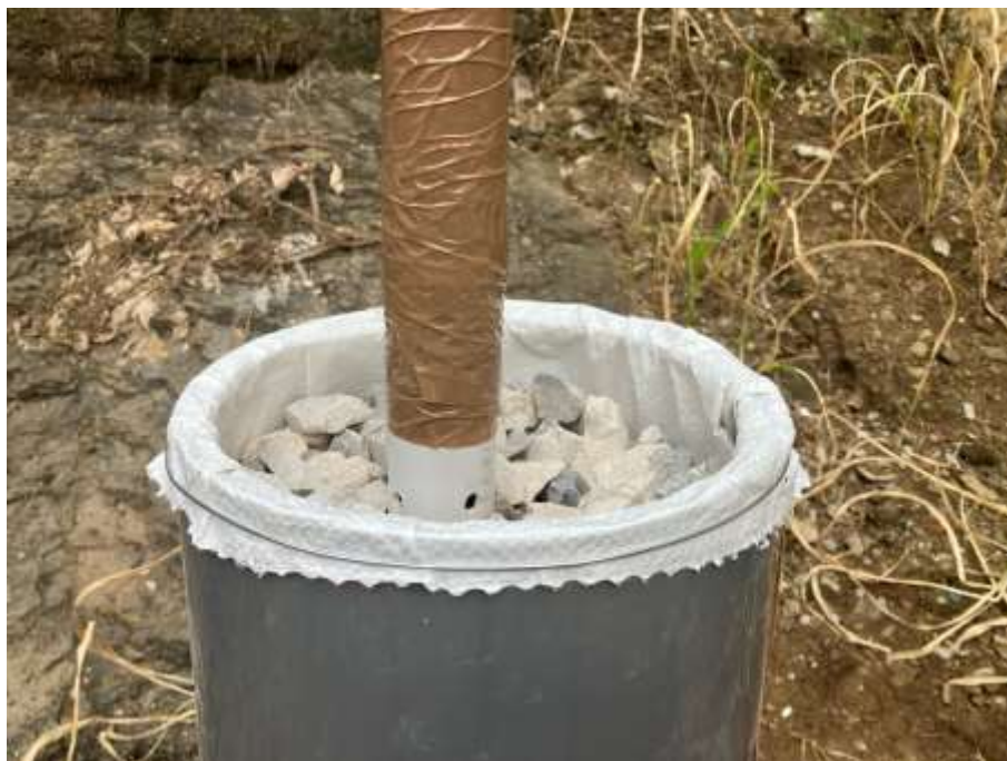
Figura 89. Columna de piedra antes de ser inyectada.
