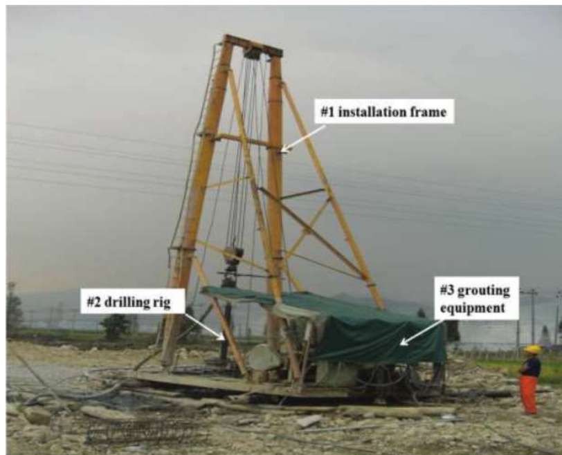
Figura 31. Marco para instalación de las columnas de grava inyectada.
