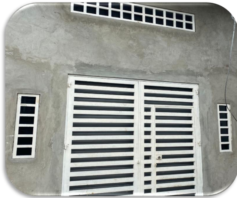
Fachada del lugar en construcción
