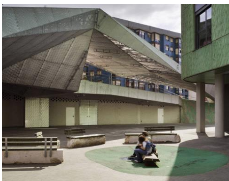
Figura 278 y 279. Plaza Portmetxeta, vista interior y exterior. Fuente: CiangMag (2012).
