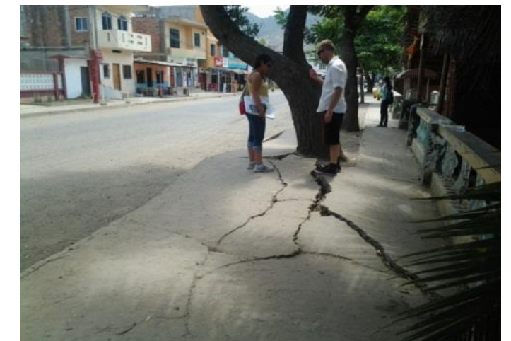
Figura 15. Acera destruida. Fuente: Grupo de trabajo de titulación de Arquitectura (2013) Elaborado por: La Autora (2014)
