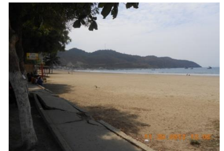
Figura 13. Vereda destruida. Fuente: Grupo de trabajo de titulación de Arquitectura (2013) Elaborado por: La Autora (2014)
