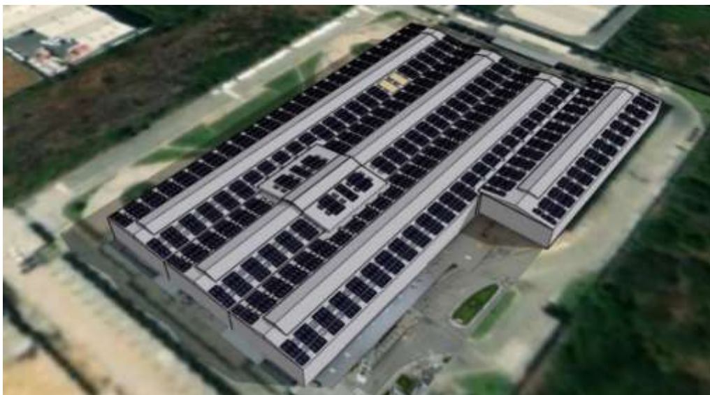
Figura 30. Instalaciones de CEDAL Durán Fuente: El Autor
