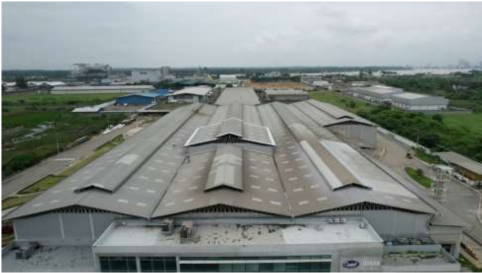
Figura 29. Instalaciones de CEDAL Durán Fuente: El Autor
