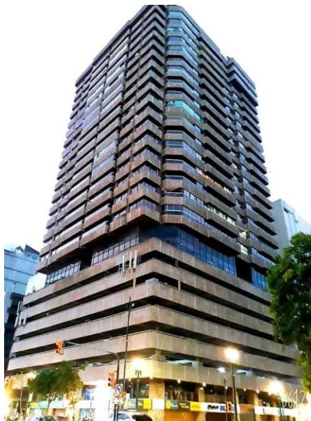
Figura 2. Edificio San Francisco 300
