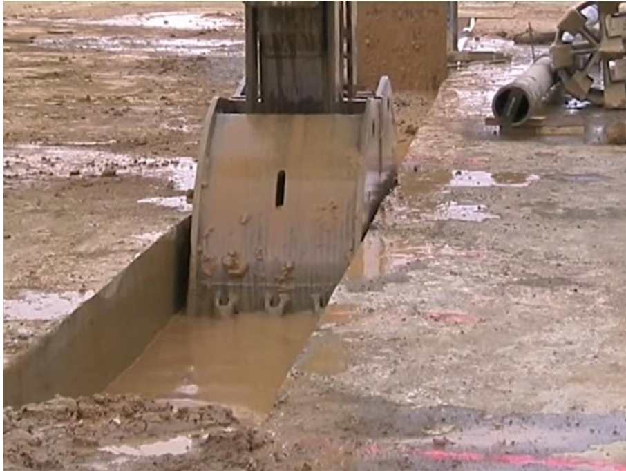
Figura 20. Bentonita estabilizando muro
