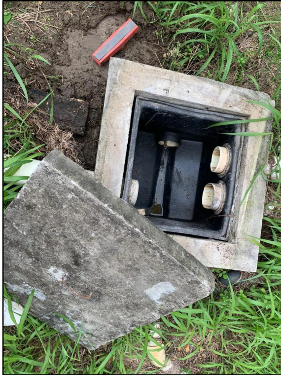
Figura 28 Caja de registro previo al afluente del BSI – Piladora de Cesa donde se introduce el trazador disuelto completamente en agua por dosificación instantánea.
