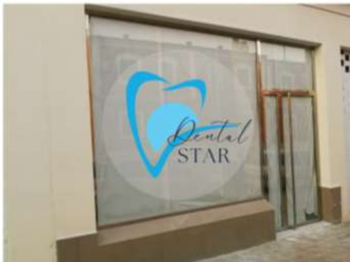
Figura 53. Fachada del consultorio
