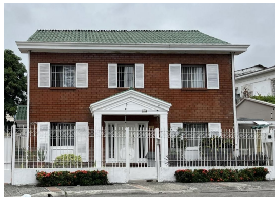
Figura 28. Calle Dolores Sucre. Fuente: Foto tomada por autores.
