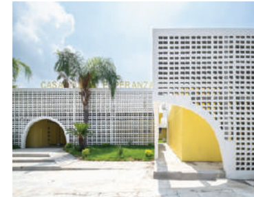
Figura21. Foto exterior proyecto centro comunitario casa nueva esperanza. Fuente: Archdaily
