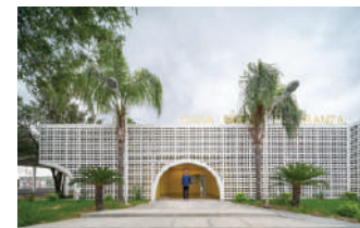
Figura 23. Foto exterior proyecto centro comunitario casa nueva esperanza. Fuente: Archdaily
