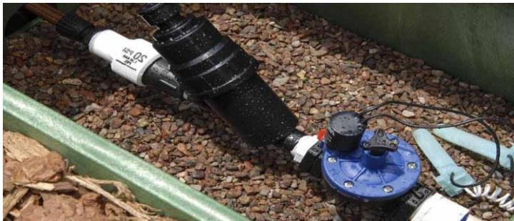
Figura 5 Electroválvula conectada
