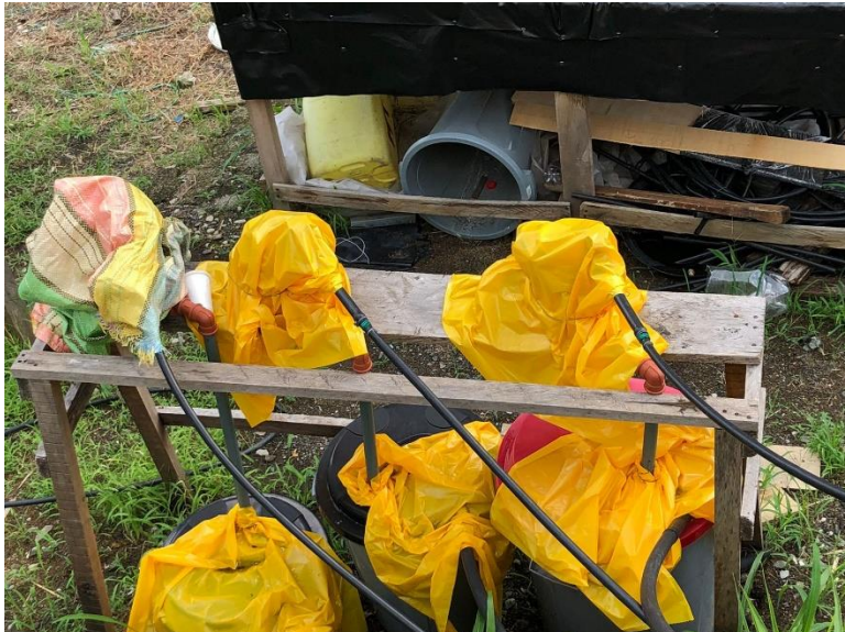
Figura 28 Bombas de agua de huerto sin automatizar
