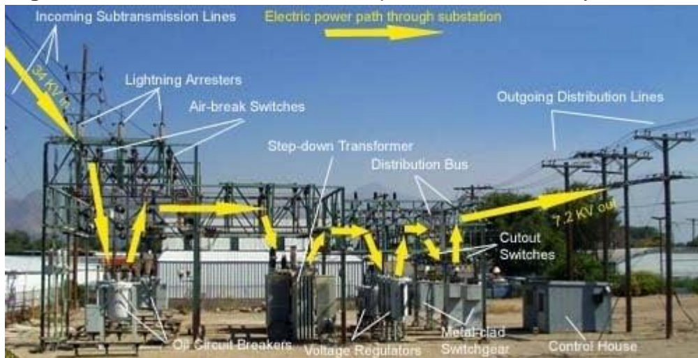
Figura 2.12: Sistema de distribución para mantenimiento y revisiones
