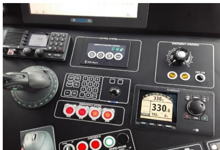
Figura 3. 9 Equipos de radio comunicación y navegación
