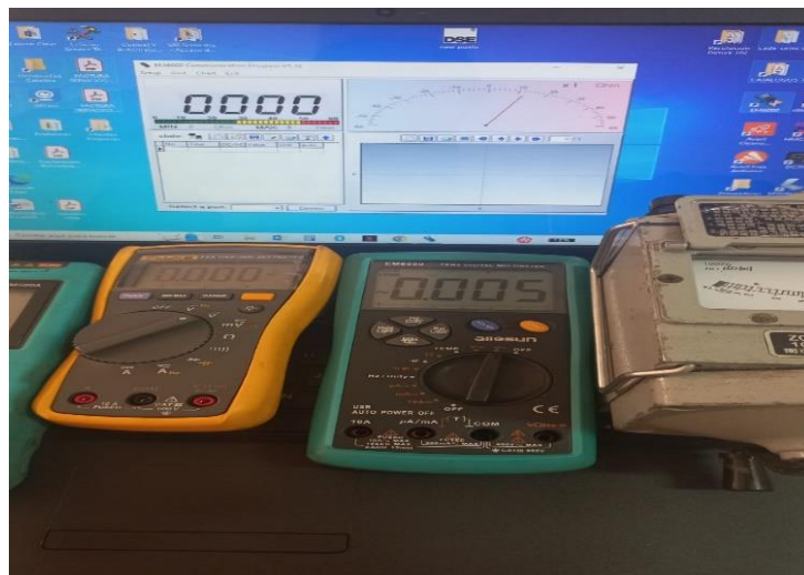
Figura 3. 11 Equipos para el monitoreo de fugas a tierra
