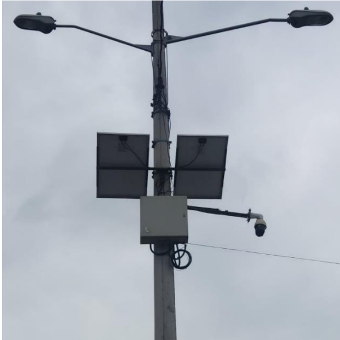
Figura 3. 14 Instalación en sitio
