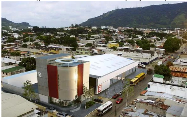
Figura 15. Centro Integral de Mantenimiento CIM y edificio corporativo GRUPO FJ
