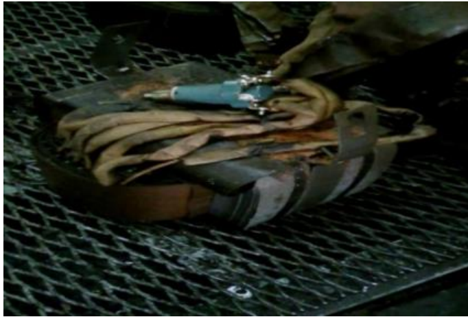
Figura 4. 5 Presencia de óxido debido a la falta de hermeticidad
