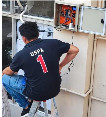
Figura 92: Instalación de la estación meteorológica
