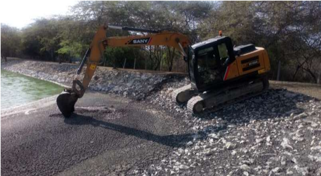
Ilustración 24 - Maquinaria recogiendo los lodos producidos cerca de los taludes de las lagunas
