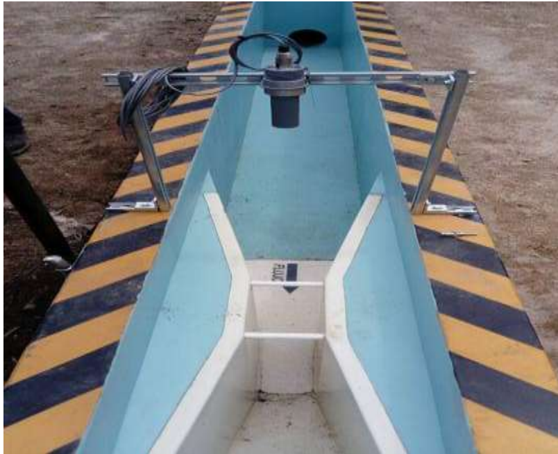
Ilustración 22 - Canaleta Parshall
