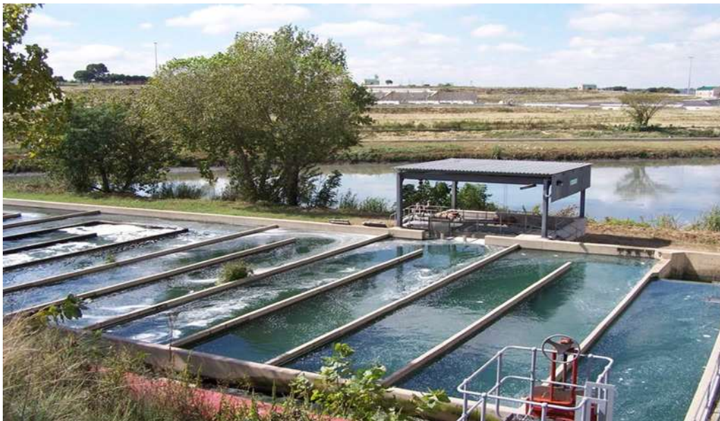
Ilustración 25 - Tanque de contacto de cloro
