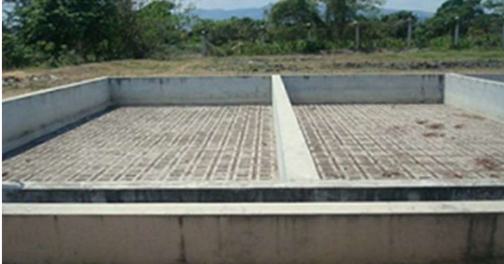
Ilustración 23 - Lechos de secado
