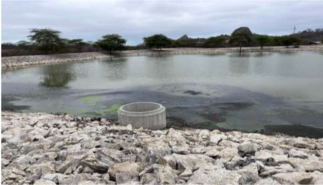
Ilustración 18 - Laguna facultativa "L1" con presencia de nata y sedimentos
