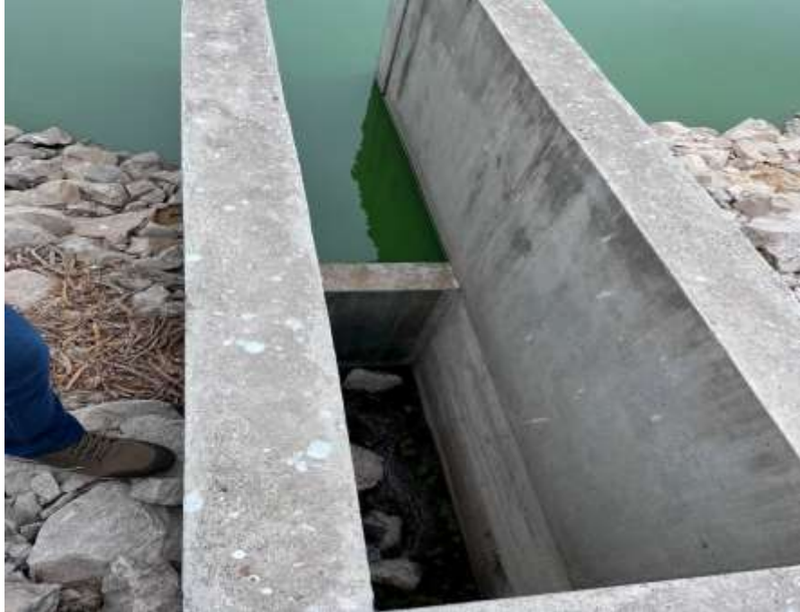
Ilustración 15 - Estructura de descarga con vertedero
