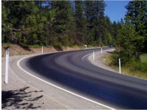
Figura 8.- Pavimento con exudación. Tomado de: Clases de la asignatura de Pavimentos. UCSG. Ing. Rolando Vila, 2020.
