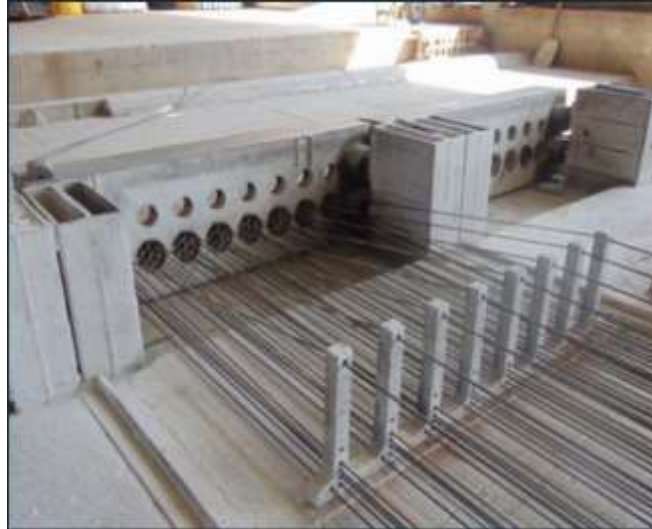
Figura 11. Acero de presfuerzo tensado.
