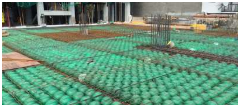
Figura 3. Vista en obra de la losa Bubbledeck
