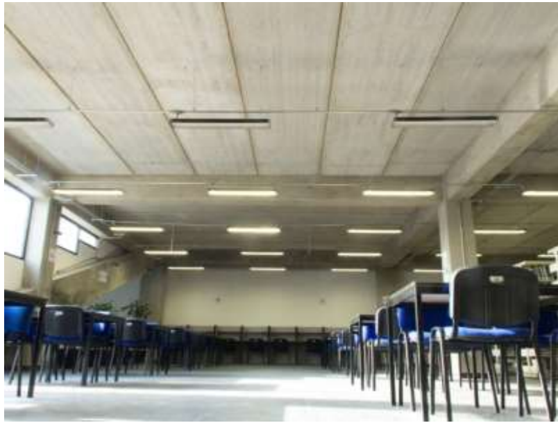
Figura 21. Acabado final de la losa alveolar.
