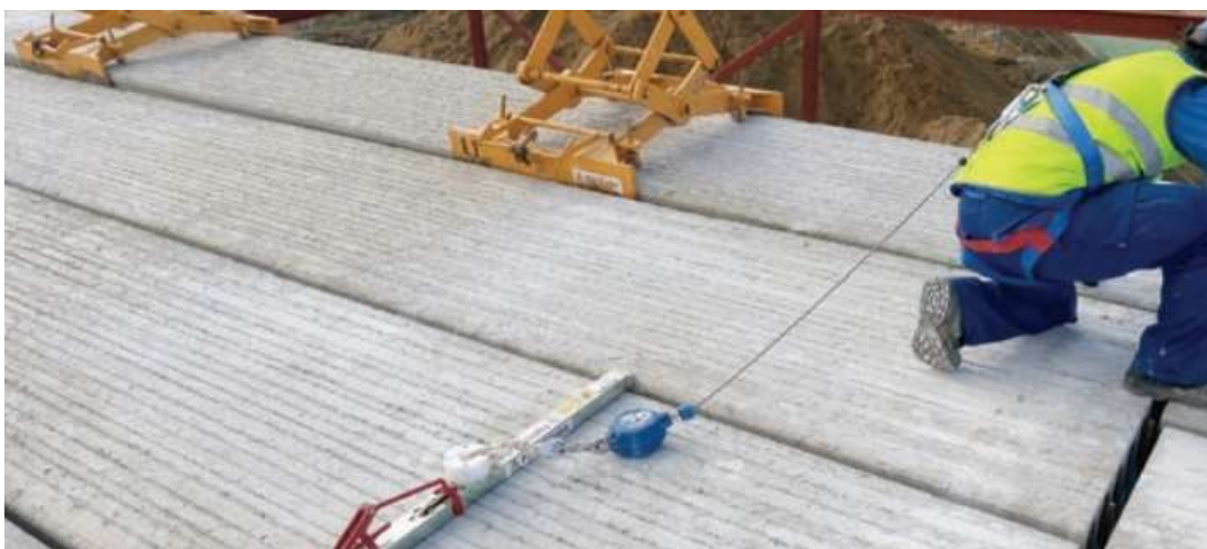
Figura 20. Colocación con pinzas
