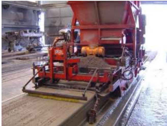
Figura 10. Colado de la losa alveolar.
