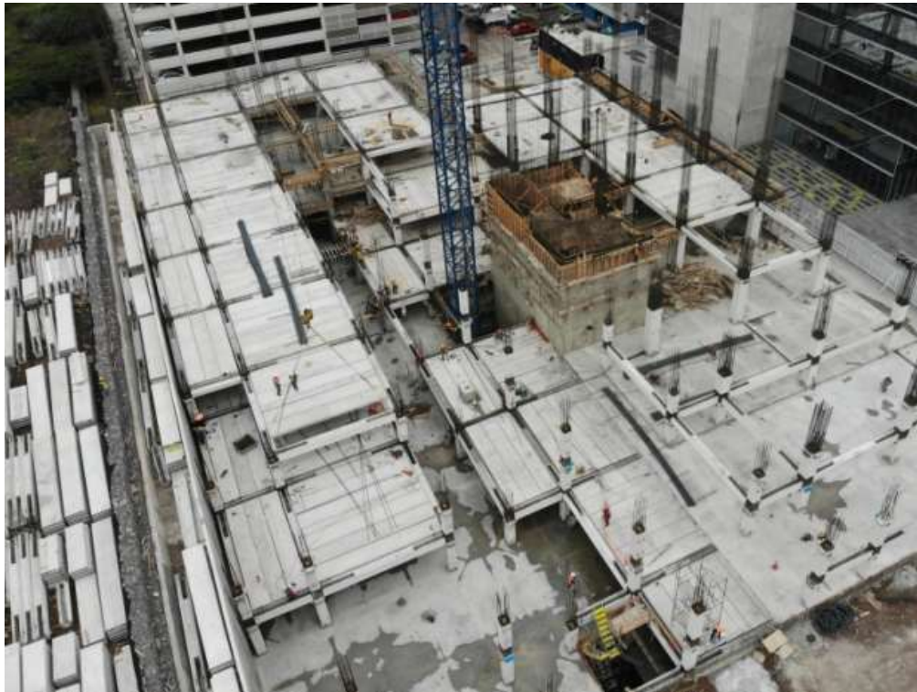
Figura 8. Sistema de entrepiso aplicando losas alveolares.
