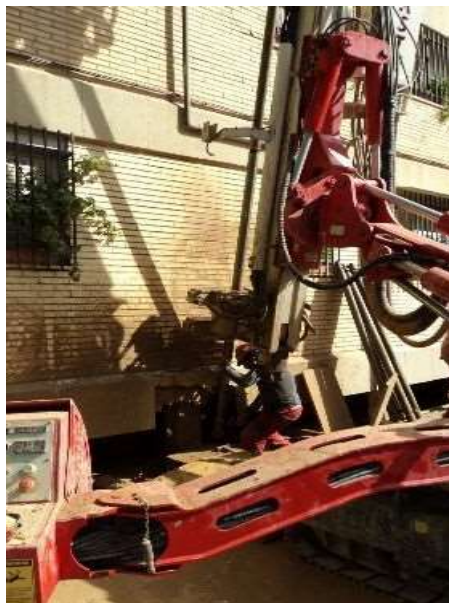
Figura 23. Colocación de armadura tubular
