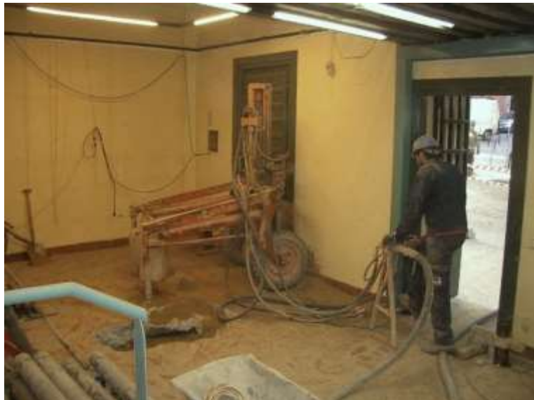
Figura 51. Ejemplo de máquina de perforación en el interior de una vivienda
