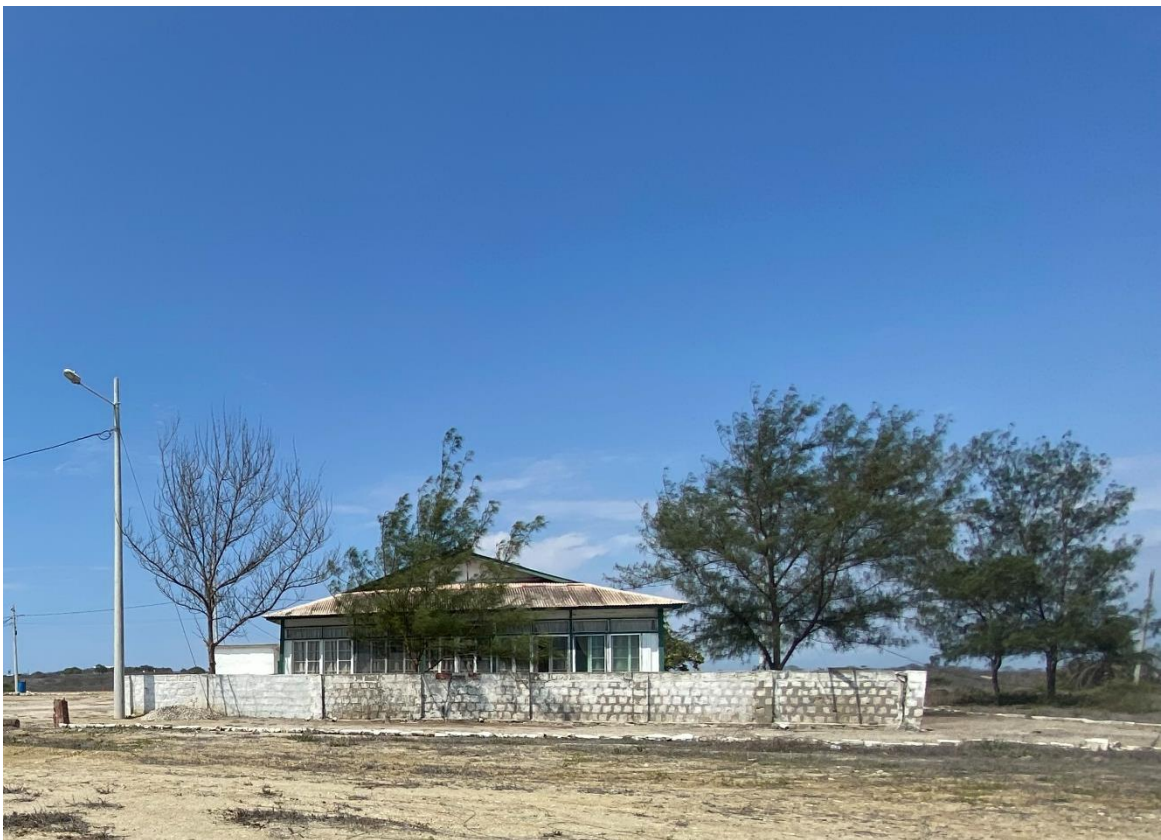
Figura 105. Fachada principal, BI_04
