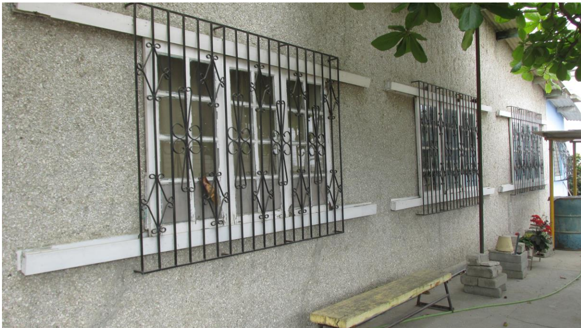
Figura 48. Detalle de ventanas
