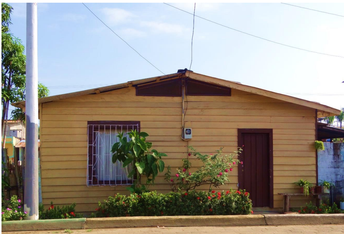
Figura 5. Vivienda en Tenguel, 2012.
