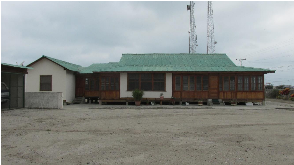
Figura 92. Fachada lateral, Casa galería tipo 1, Familia Sotomayor BI_02
