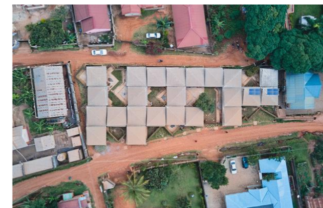
Figura: Vista aérea de La Escuela Terakoya. Fuente: ArchDaily.
