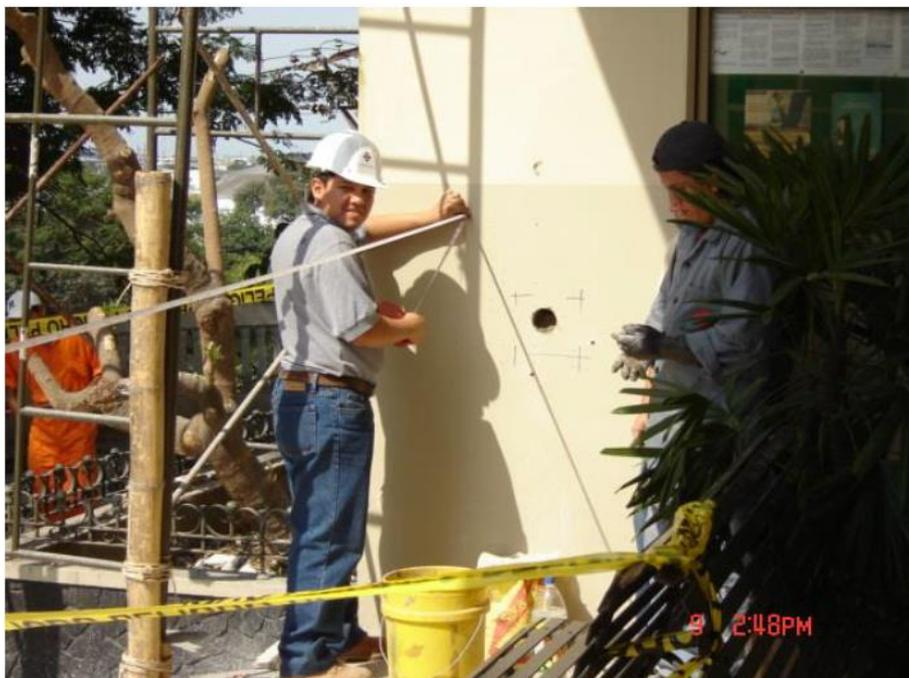
*Ilustración 31 Extracción de núcleo en planta baja y determinación de dimensiones. Fuente: Laboratorio de estructuras y suelos 2006.*
