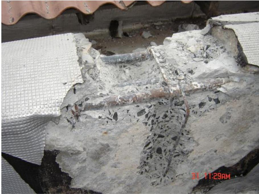
Ilustración 32 Investigaciones de vigas de cubierta. Fuente: Laboratorio de estructura y suelos 2006.
