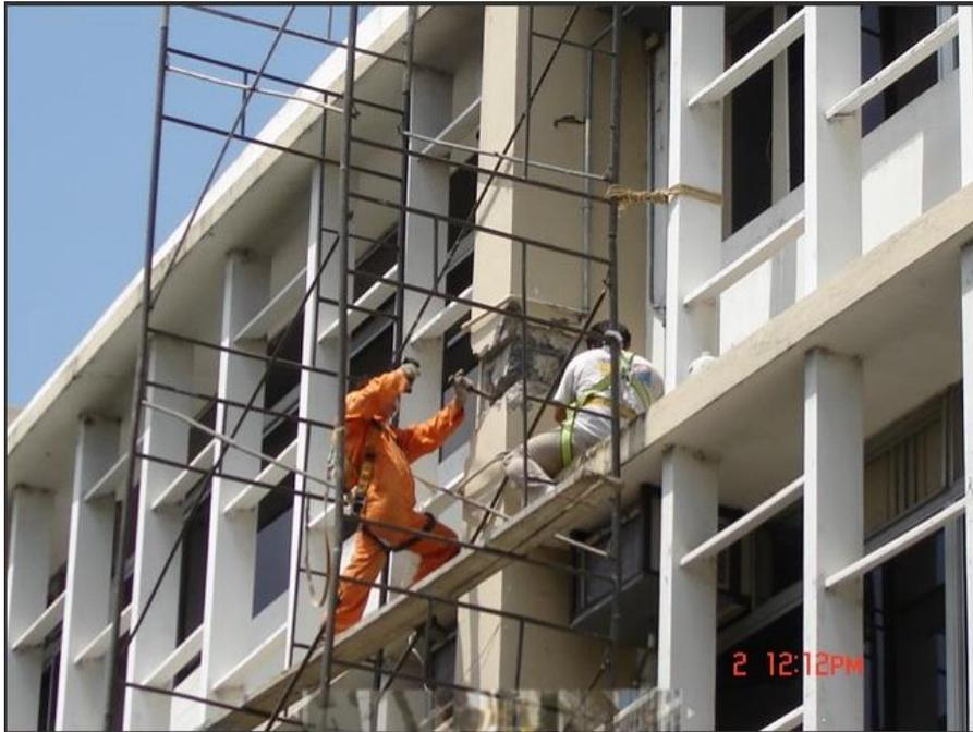
*Ilustración 30 Determinación de armadura en columna de 3er Piso. Fuente Laboratorio de estructuras y suelos 2006.*
