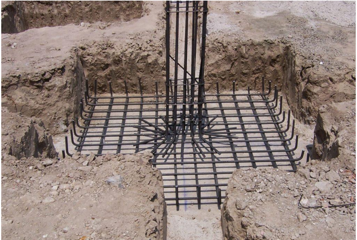
Ilustración 7. Armado de plinto.
