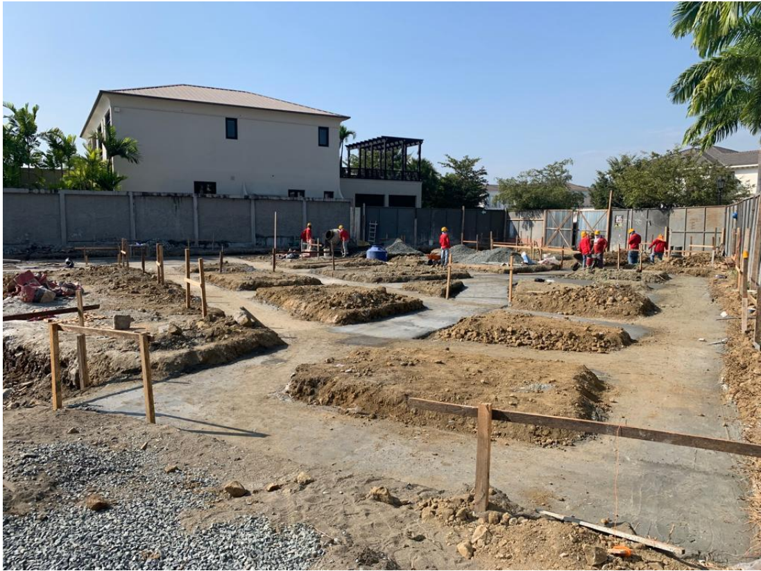
Ilustración 62. Fundición de Replanteo para Zapatas.
