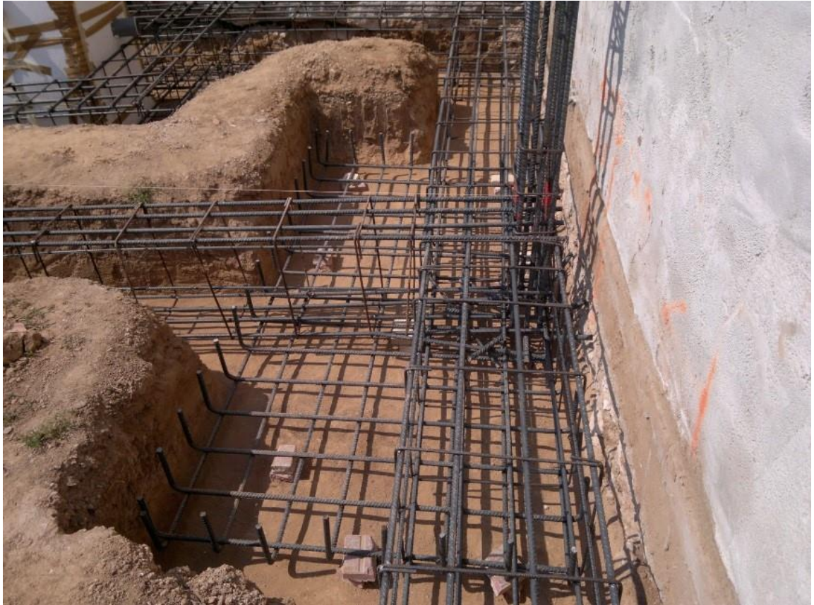
Ilustración 9. Armado de zapatas en dos sentidos.
