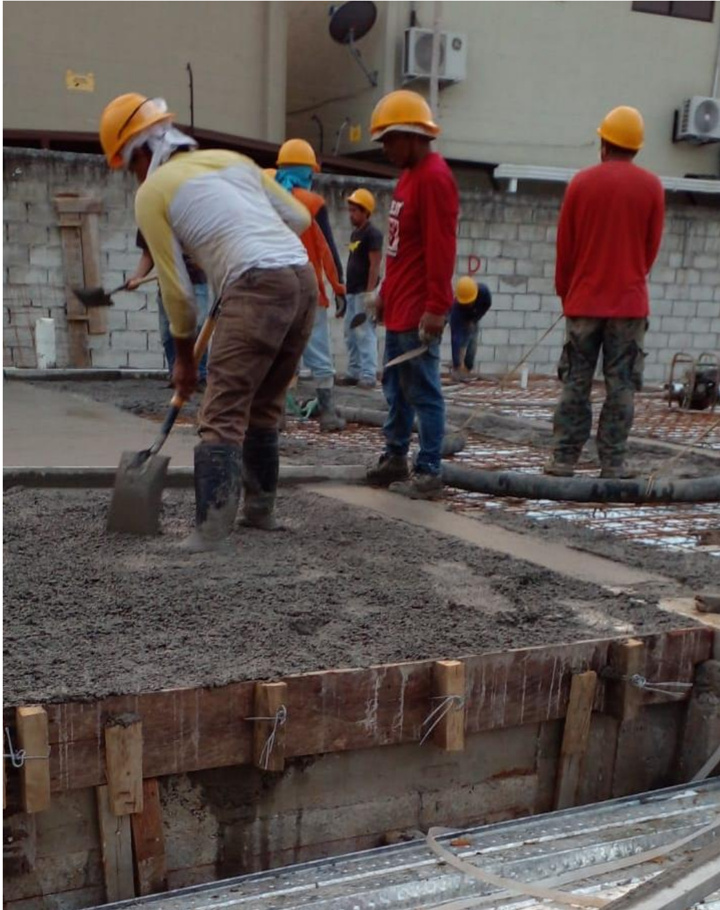
Ilustración 58. Fundición de la Losa.
