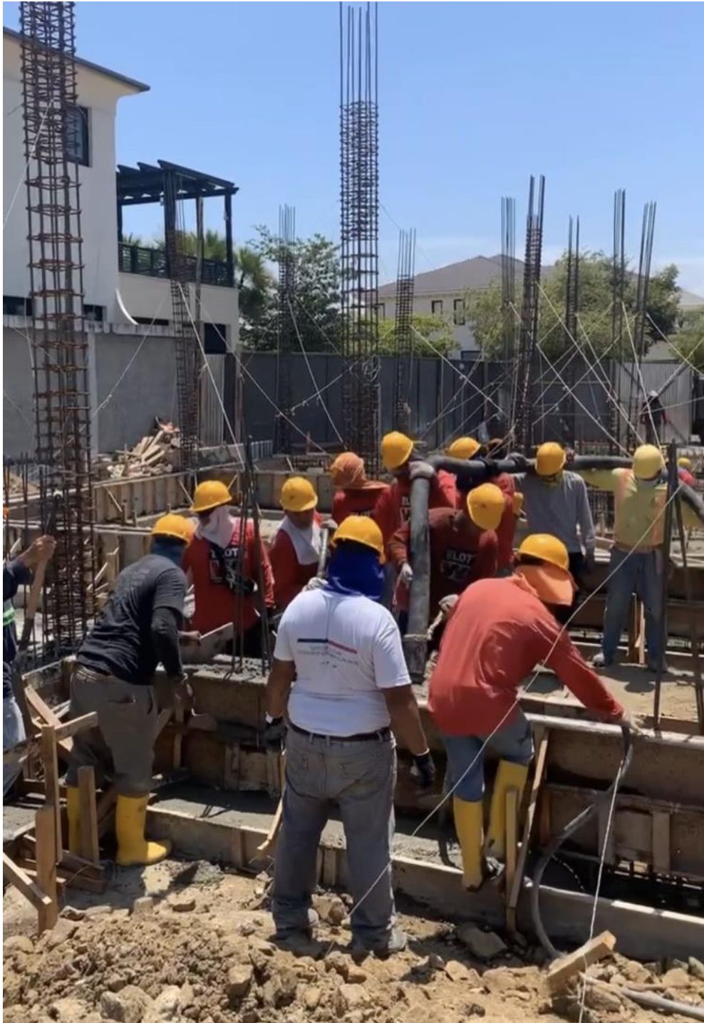
Ilustración 65. Fundición de Zapatas.
