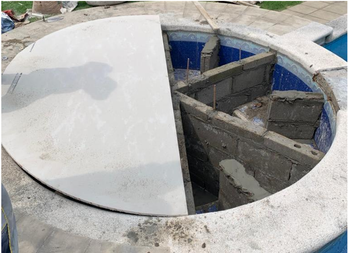
Ilustración 75. Colocación de plancha de plywood usada como encofrado para la losa.
