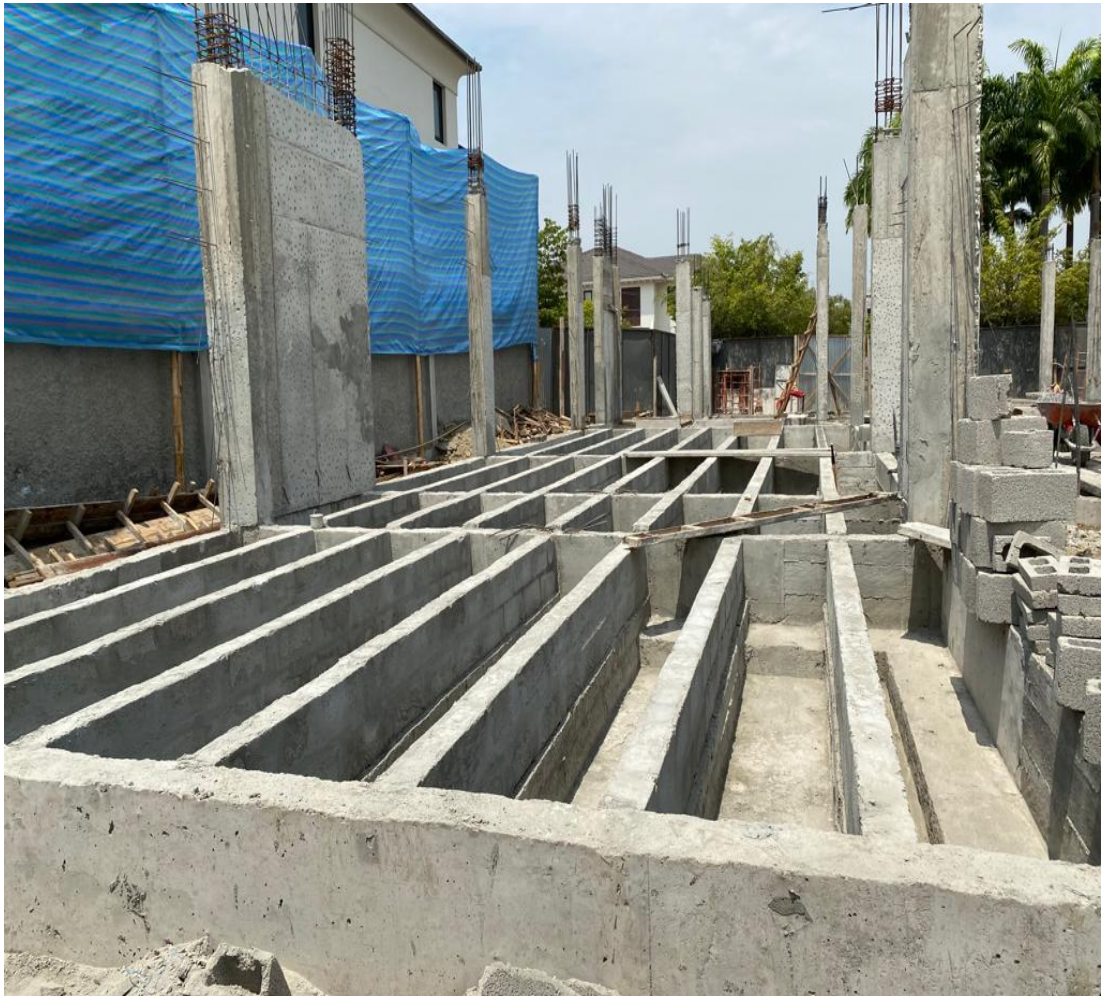
Ilustración 68. Colocación de bloques hasta nivel de vigas de cimentación.
