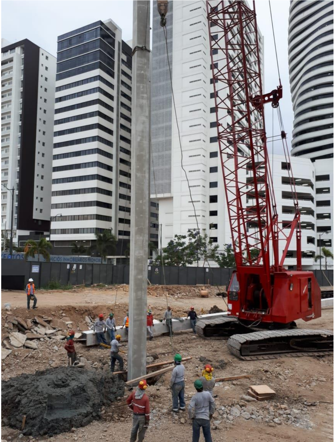
Ilustración 6. Colocación de pilote de hormigón prefabricado.
