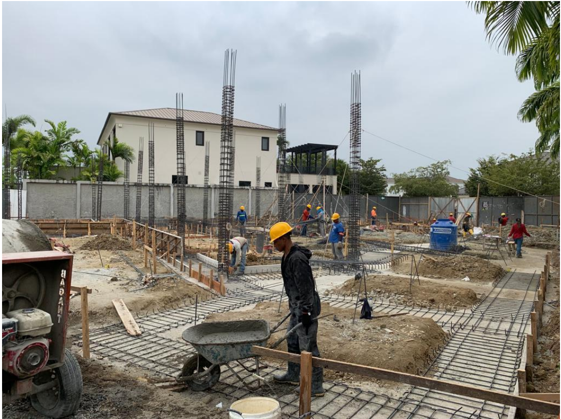
Ilustración 63. Armado de Zapatas.
