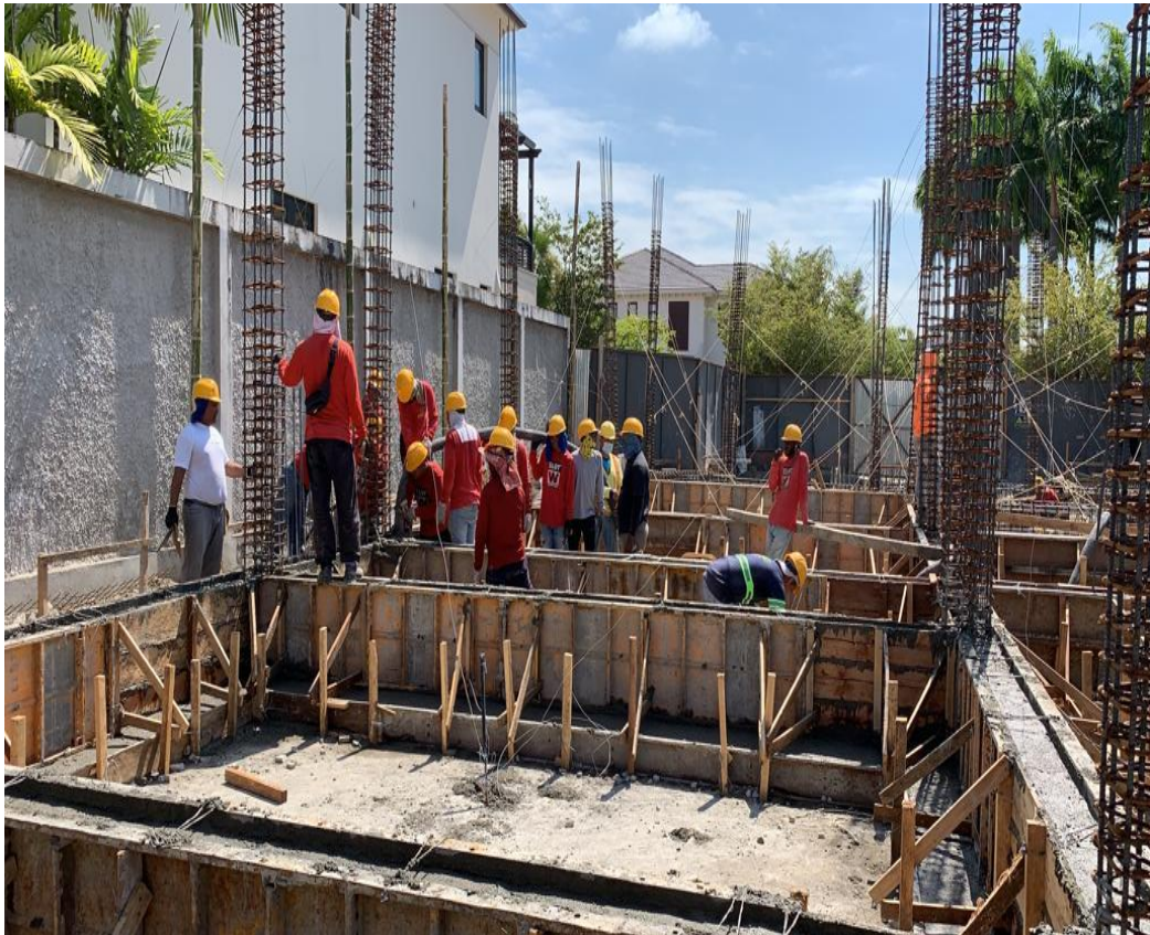
Ilustración 64. Encofrado y Apuntalamiento de Zapatas.
