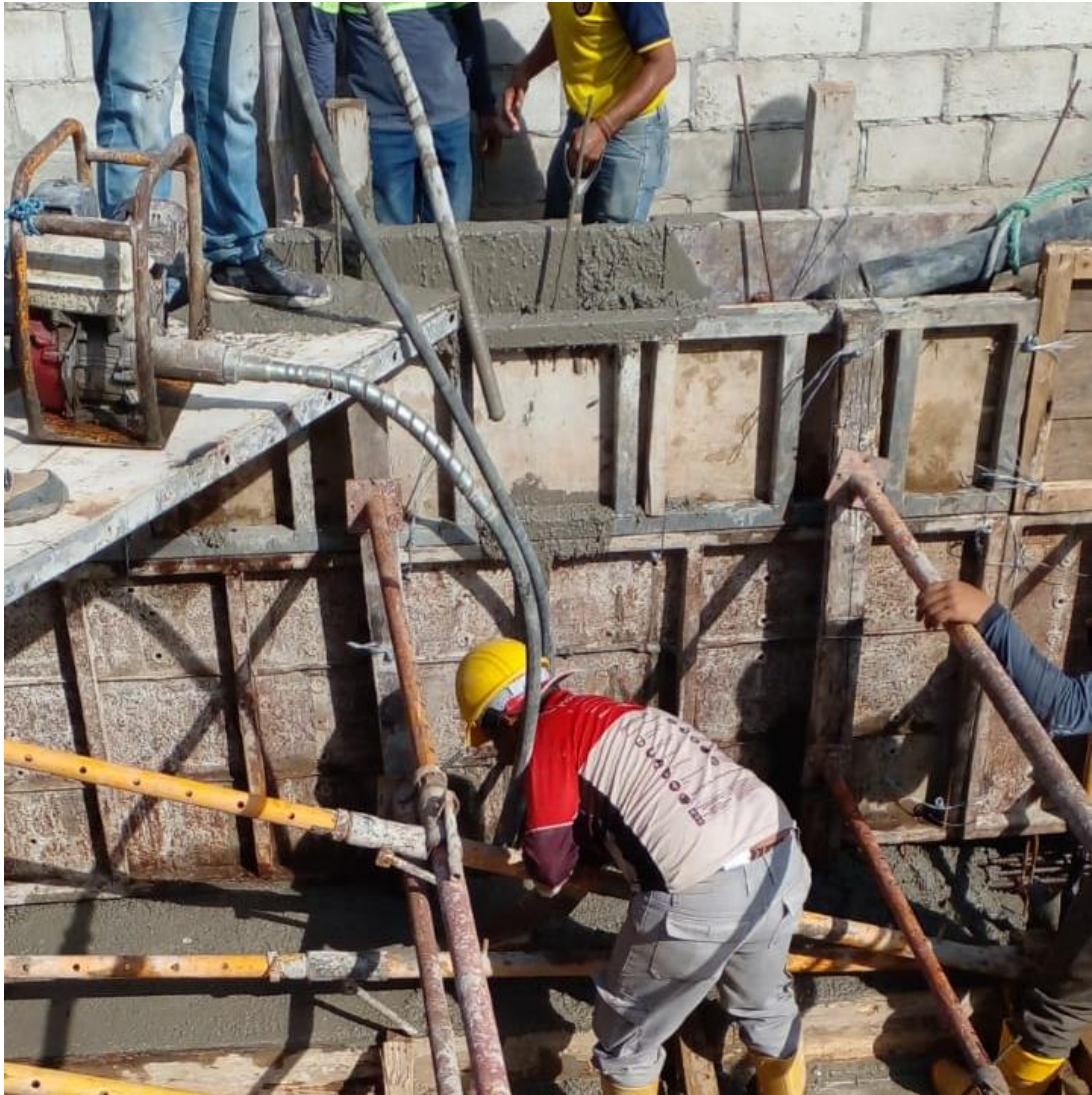
Ilustración 52. Fundición de Zapatas.
