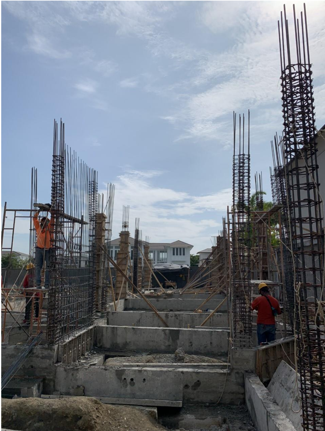
Ilustración 66. Desencofrado de Zapatas.
