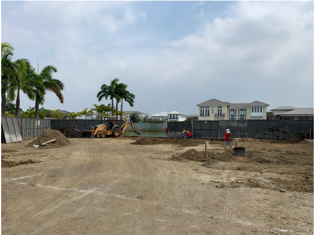
Ilustración 61. Excavación para Zapatas.
