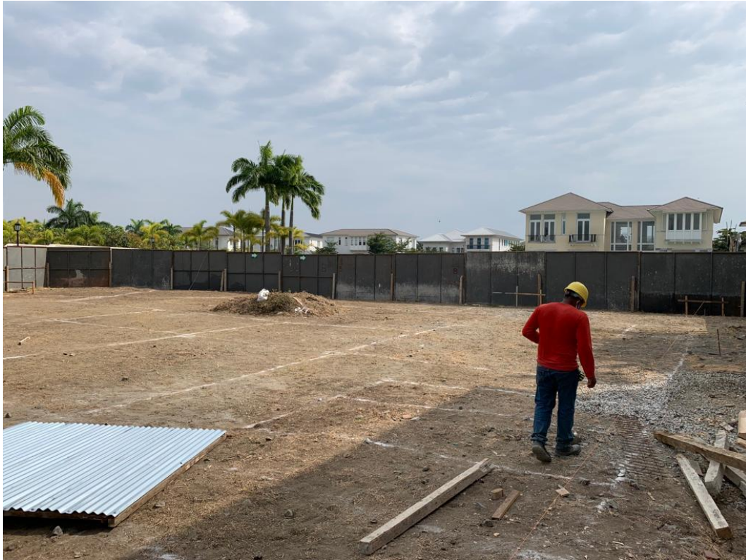
Ilustración 60. Preparación del terreno.
