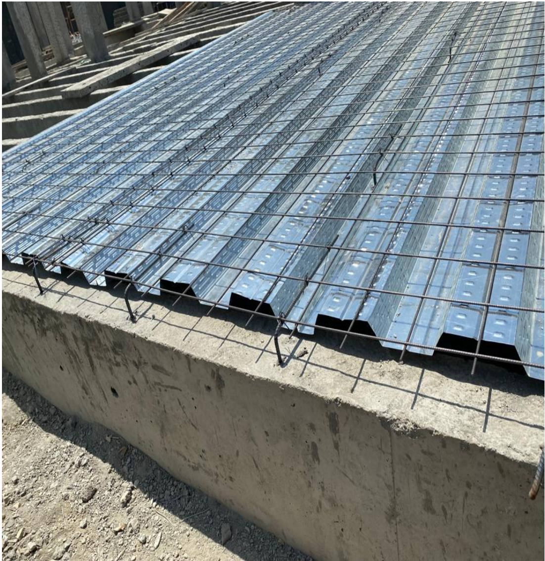
Ilustración 70. Colocación de malla electrosoldada para fundición de losa:
