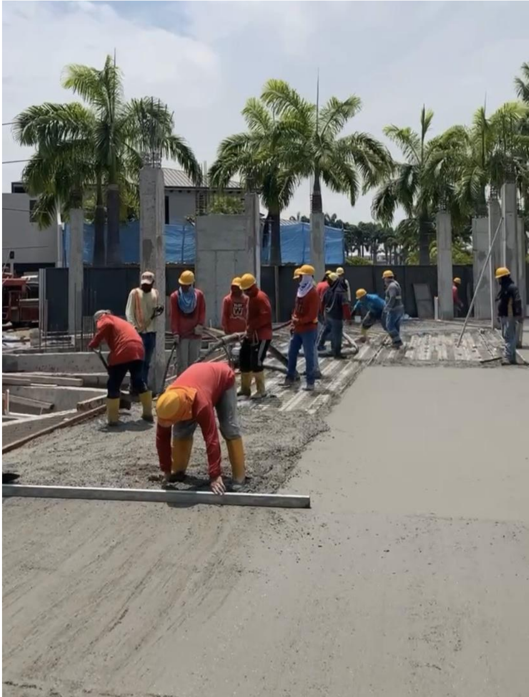
Ilustración 71. Fundición de Losa.
