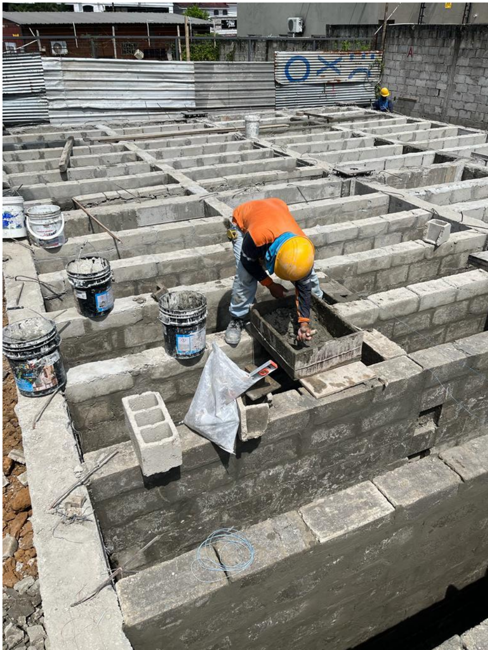
Ilustración 55. Colocación de Bloques de Refuerzo.
