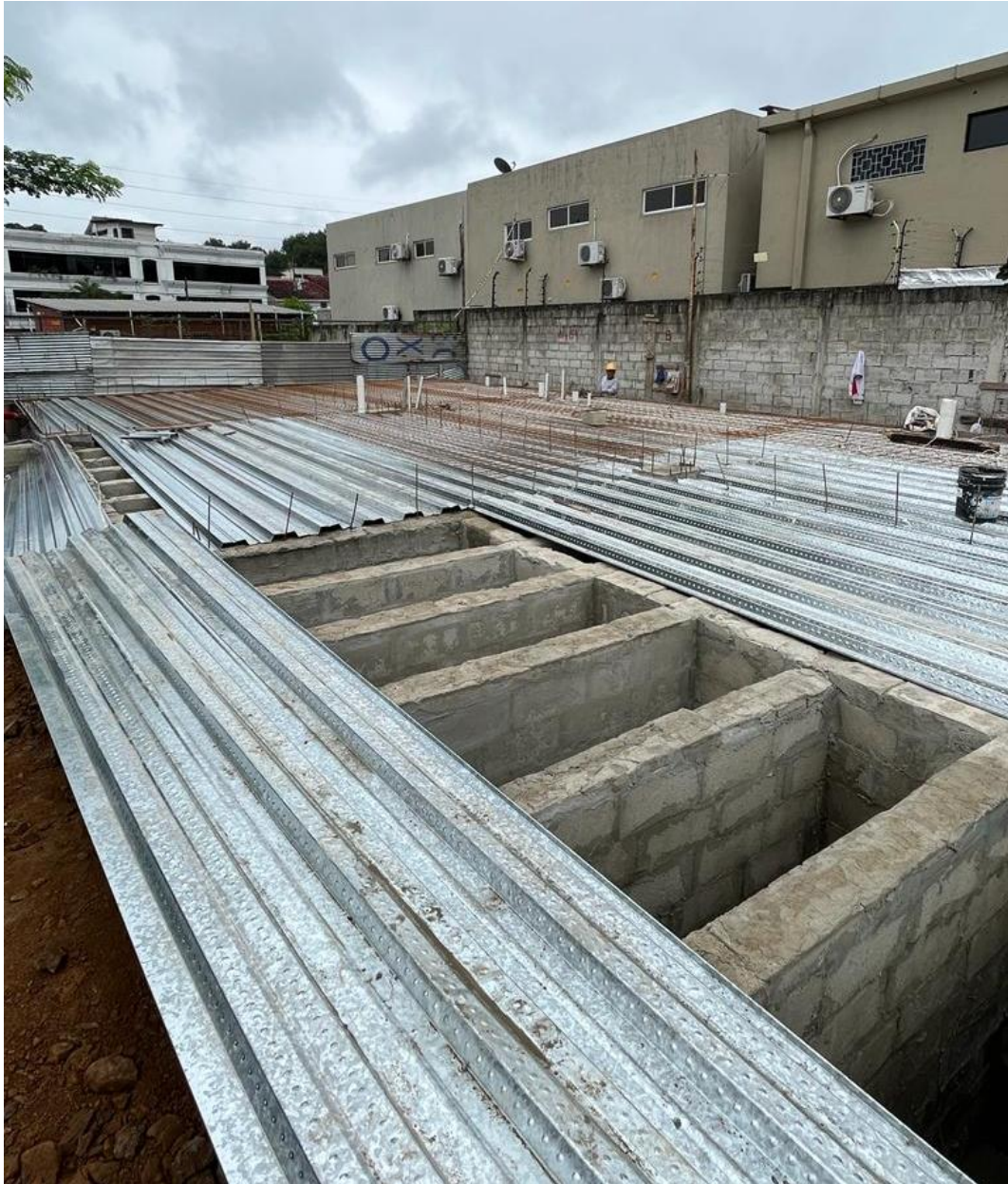
Ilustración 56. Colocación de Planchas de Steel Panel.
