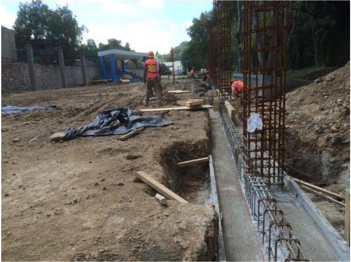
Ilustración 8. Armado de zapata en un sentido.
