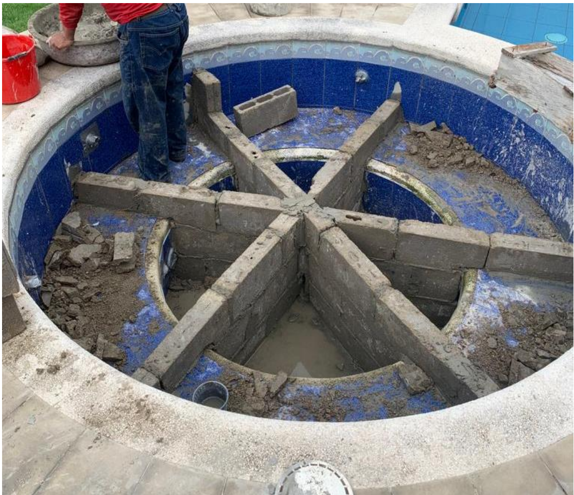
Ilustración 72. Colocación de bloques en forma determinada.
