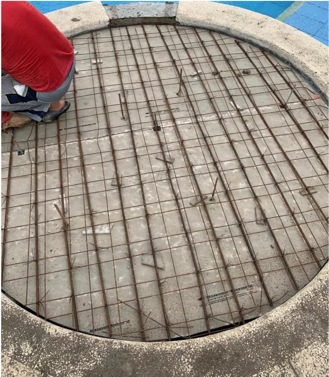
Ilustración 76. Colocación de doble malla electrosoldada para fundición de losa.
