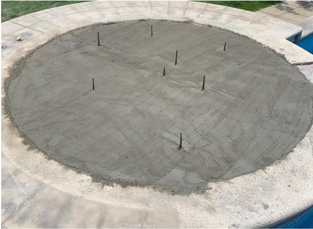
Ilustración 77. Fundición de losa.
