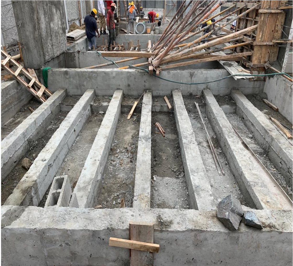
Ilustración 67. Fundición de Viguetas de Soporte para Muros de Bloque.
