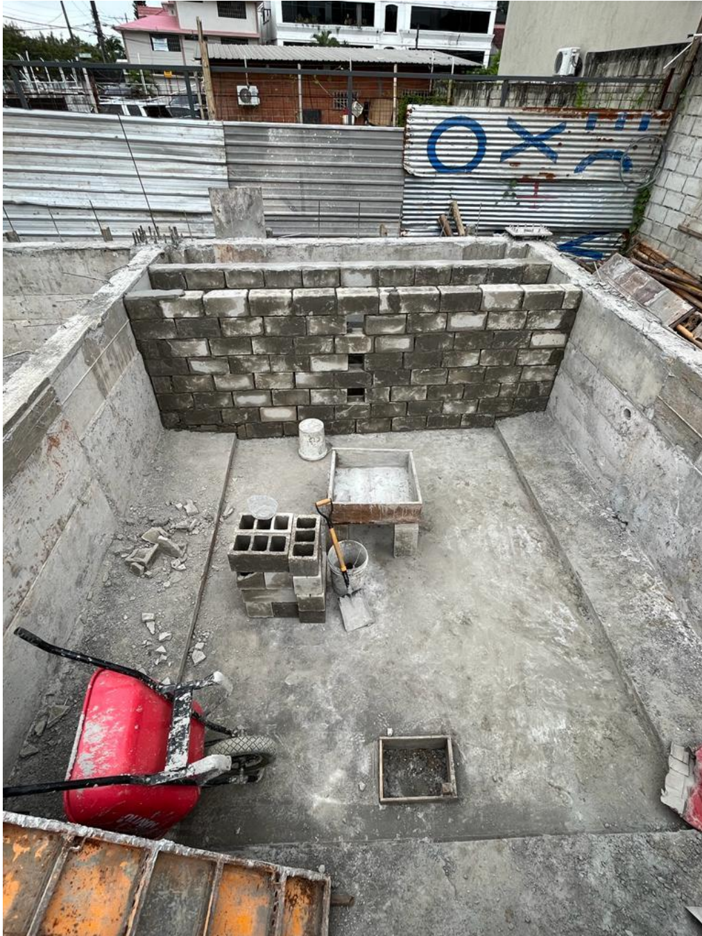
Ilustración 54. Colocación de Bloques.
