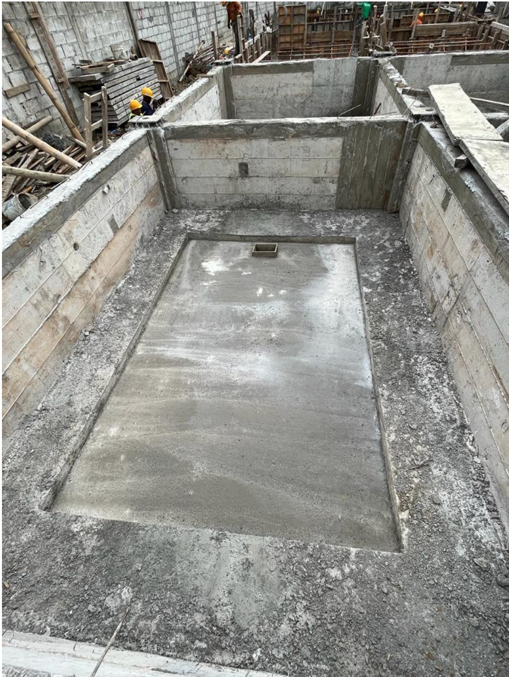
Ilustración 53. Fundición de Contrapiso en Paños Interiores para Colocar Muros de Bloque.
