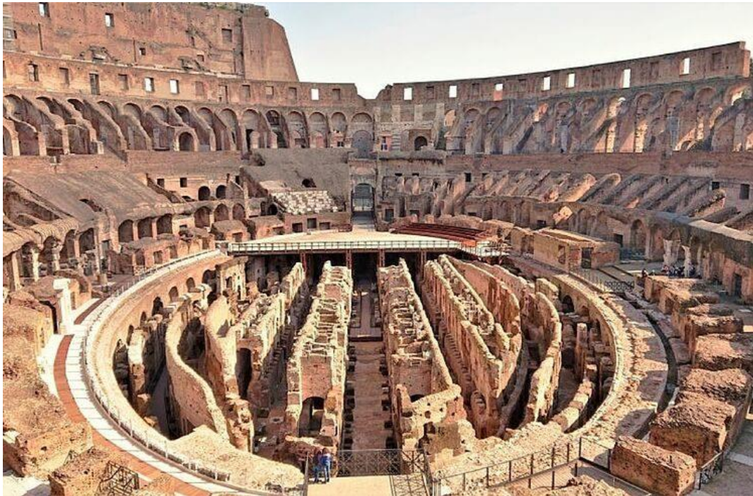
Ilustración 4. Fotografía del Interior del Coliseo Romano, en la que se puede observar los muros sobre zapatas corridas, empotrados en el suelo subyacente, sobre los que el entibado de madera, constituía el soporte de la arena. (Tandazo, E. & Ramírez, J., 2009)
