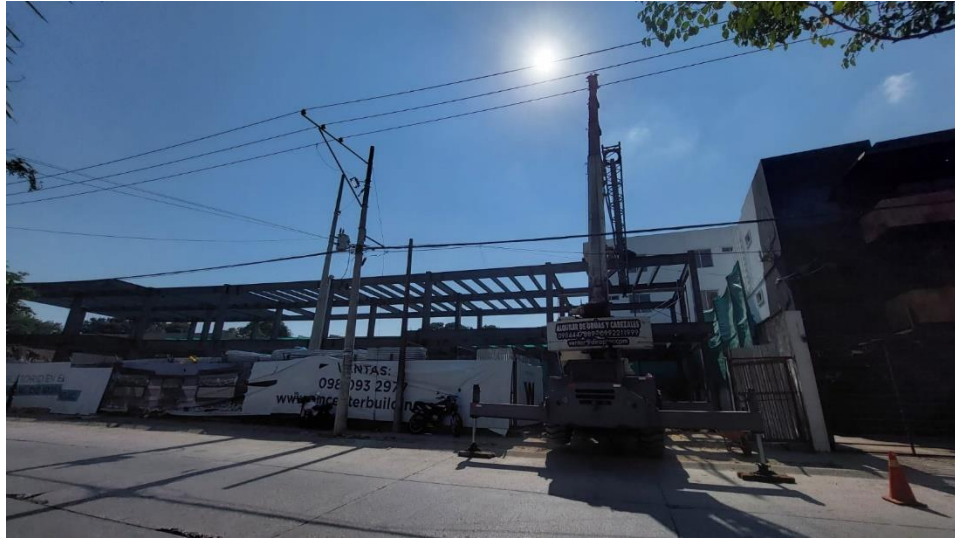
Ilustración 19. Obra OM Center en su estado actual.
