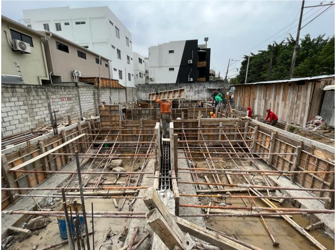
Ilustración 51. Apuntalamiento de Zapatas.
