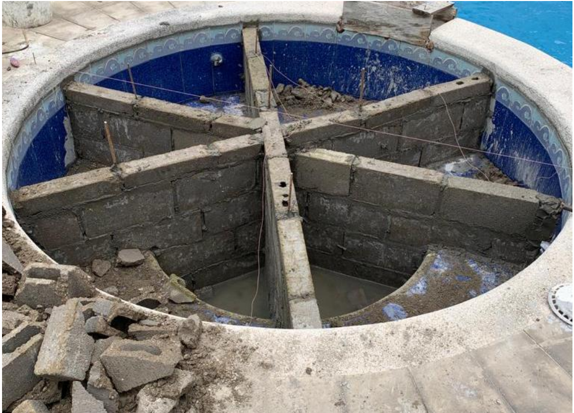
Ilustración 73. Colocación de bloques hasta nivel requerido.
