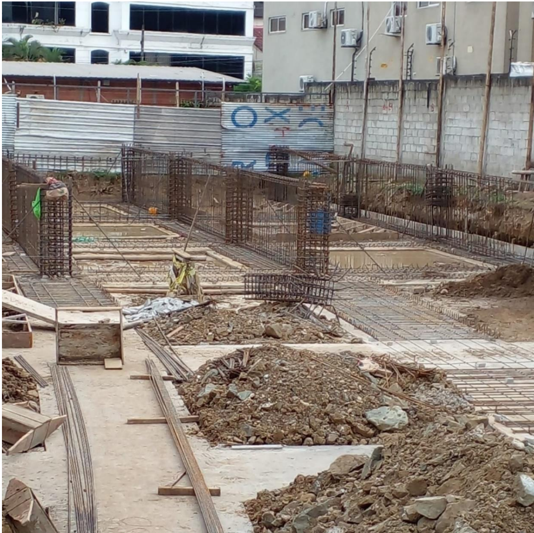
Ilustración 49. Armado de Zapatas.
