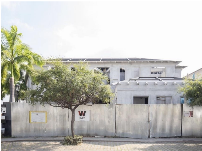
Ilustración 26. Obra HA en su estado actual.
