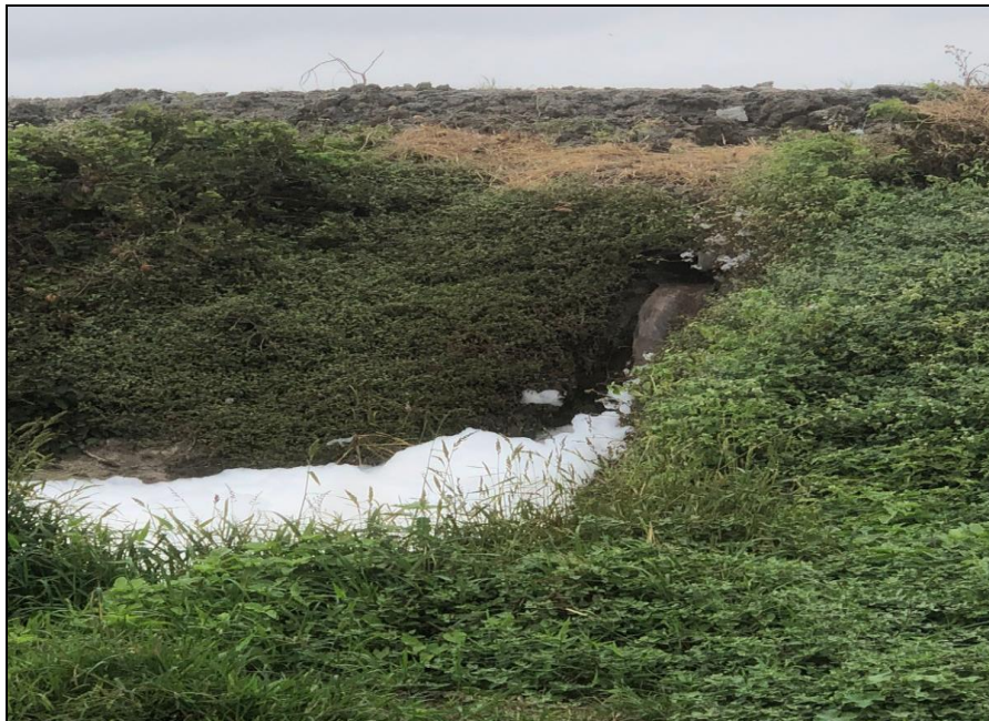
Foto 61 Descarga de la laguna de oxidación
