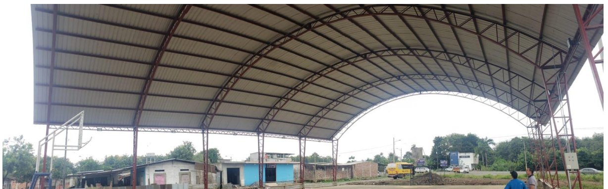
Figura 1 Galpón de estructura metálica.
