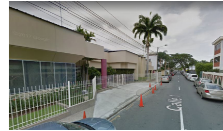
Calle 1. señalización en el piso, berma. Fuente: Google; enero 2015
